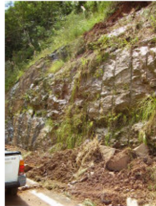
Foto 3 - Corte - Entrada do 2º Túnel
