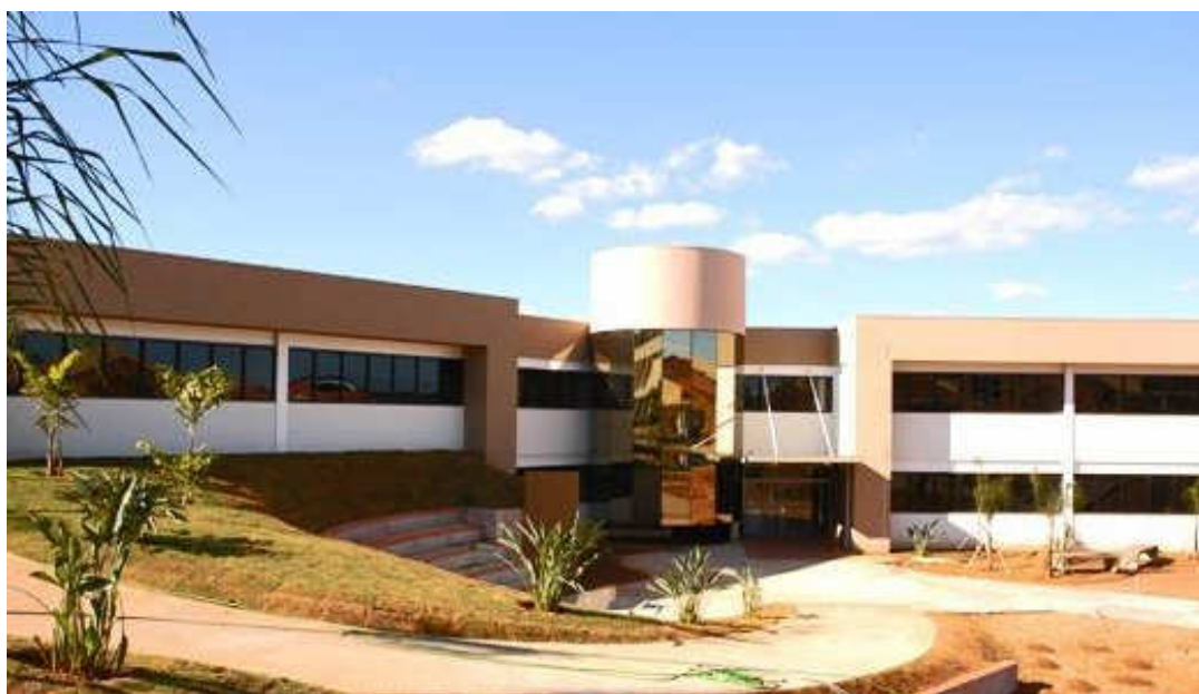
Foto 5 – UNIFRAN – Bloco Ouro – salas de aulas Fonte: UNIFRAN, on-line.
