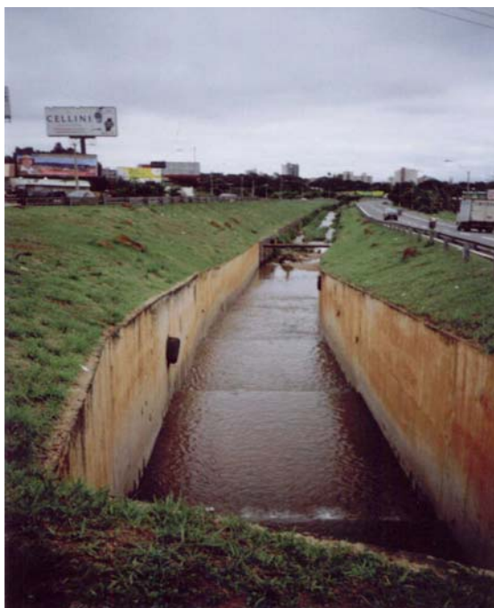
Ilustração 5 – Transição em concreto sob viaduto seguida por gabião – Córrego Botafogo em Goiânia, Goiás
