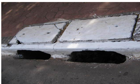
Ilustração 12 – Boca de lobo disposta sob o passeio
