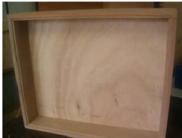
Figura 4.10 – Instalação do Compensado de 4 mm.
