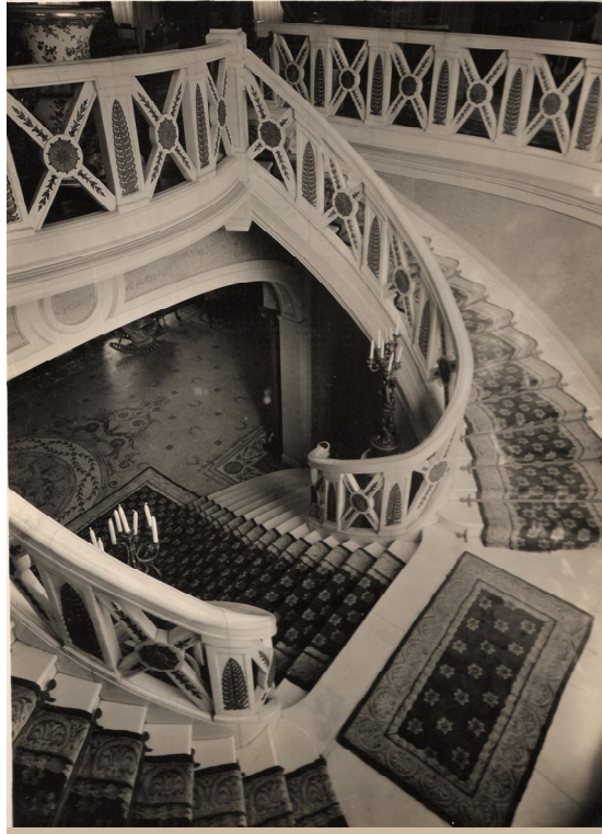
Imagem 46 A escadaria e seu guarda-corpo inspirado no na balaustrada da escadaria do Palácio Real de Nápoles. Década de 1940. Acervo Tereza Castelo Branco.
