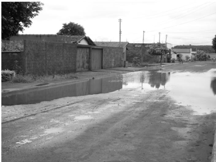
**Figura 8: Empoçamento por falta de redes de microdrenagem**
