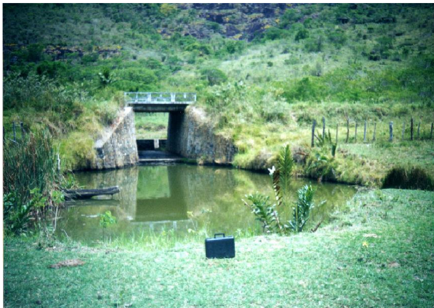
Figura 3 - Visão geral do ponto 2, localizado no rio Conceição, em fevereiro de 2003
