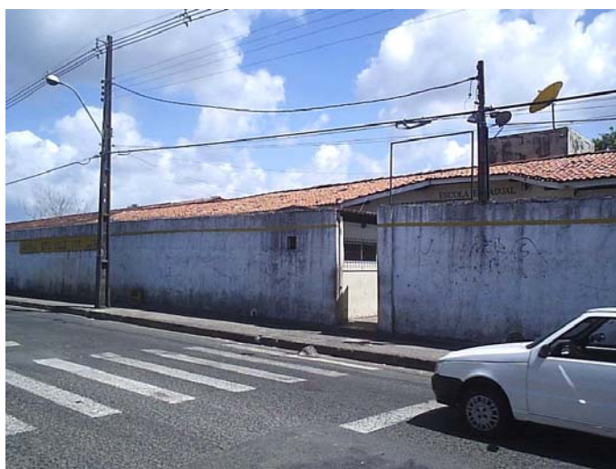
Figura 54: Escola Estadual de Primeiro Grau Vale dos Lagos (nov. 2007)
