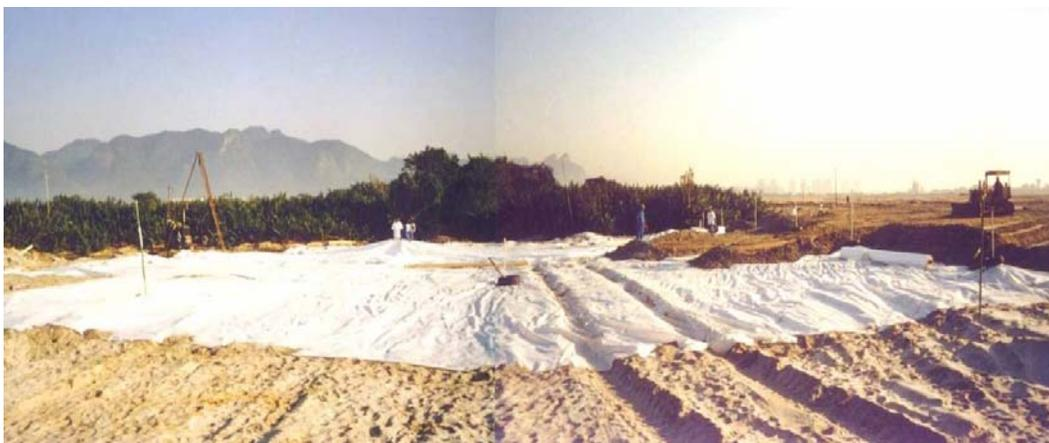
Foto 18 – Aplicação de geotêxtil no trecho especial.
