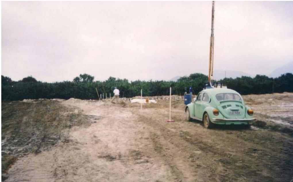
Foto 13 – Instalação das típica das placas de recalque nas adjacências do inclinômetro no trecho especial..
