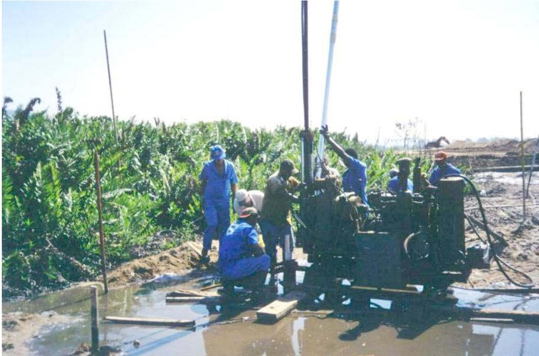
Foto 11 – Instalação do inclinômetro nas adjacências do trecho especial.
