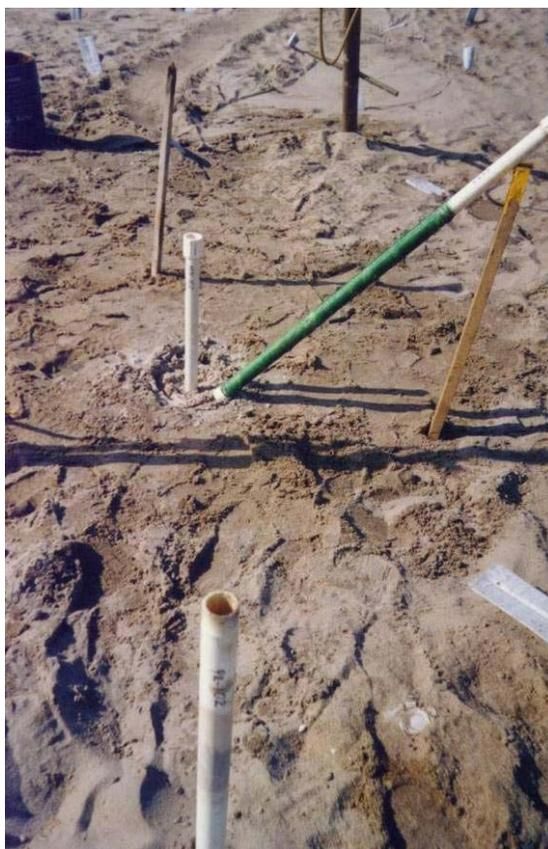
Foto 9 – Piezômetro Casgrande instalado. Ao lado medidor de nível de água a ser instalado.
