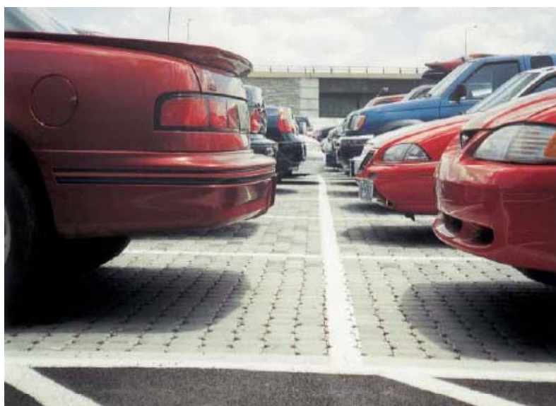
Figura 3.23 - Pavimento poroso em estacionamentos (WOODWORTH, 2002).
