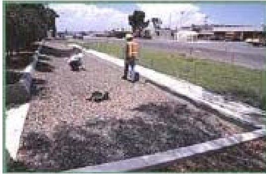
Figura 3.36 - Trincheira de Infiltração (AMEC, 2001).
