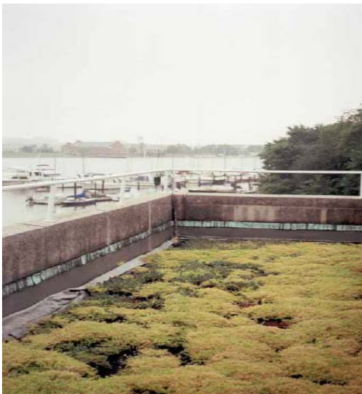
Figura 3.20 - Detenção em telhados (WOODWORTH, 2002).
