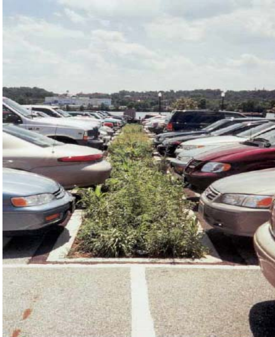
Figura 3.37 - Trincheira de infiltração (WOODWORTH, 2002).
