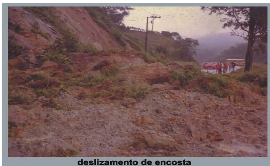
Figura 3.13 - Deslizamento de encosta
