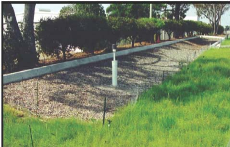
Figura 3.38 - Trincheira de Infiltração (CASQA, 2003).
