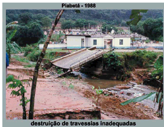
Figura 3.14 - Conseqüências da diminuição da seção de escoamento (SEMADS, 2001).
