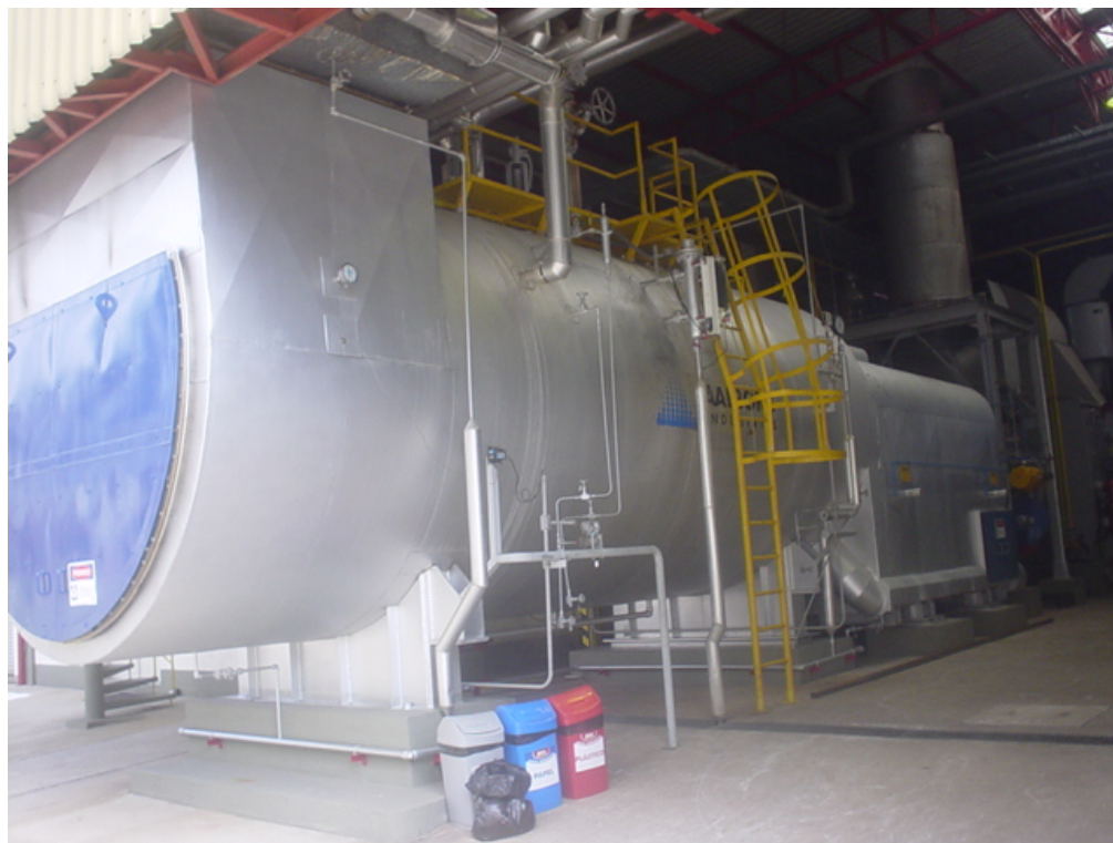
Figura 11 – Foto da Turbina e Caldeira do Sistema de Cogeração de Energia Elétrica e Térmica movido à Gás Natural
