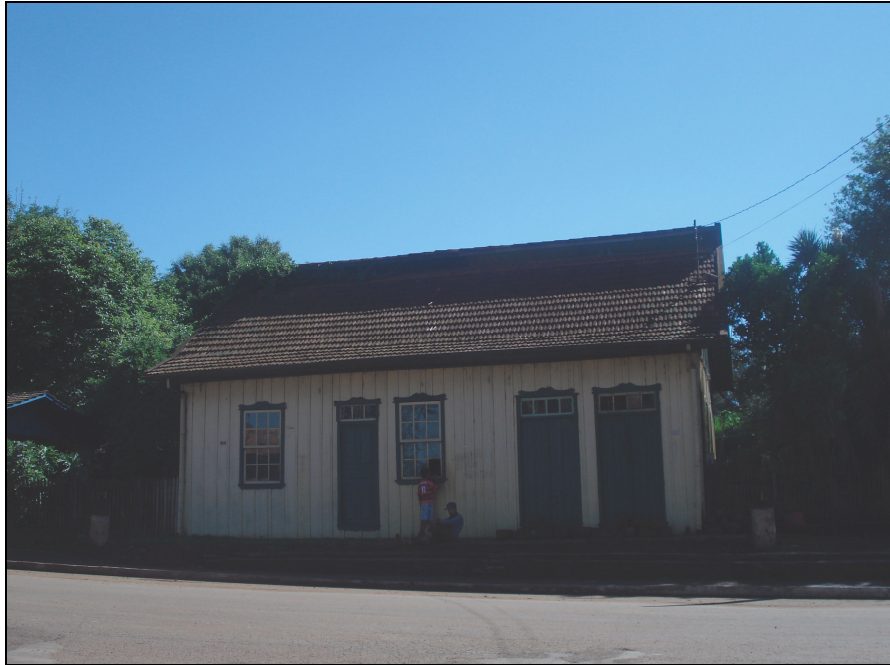
Antigo armazém Fotografia: Sônia Marques
