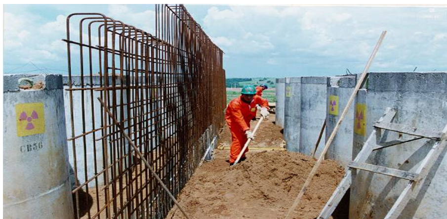
Figura 1: Construção do depósito de Abadia de Goiás (GO)
