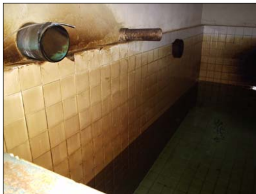
Figura 4.4 – Tanques da elevatória do Horto Florestal
