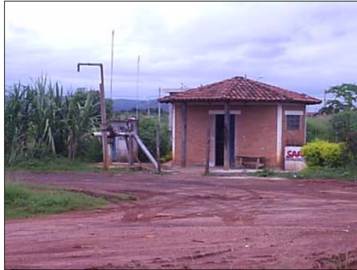
Figura 4.8 – Casa de química do Poço Cidade de Deus
