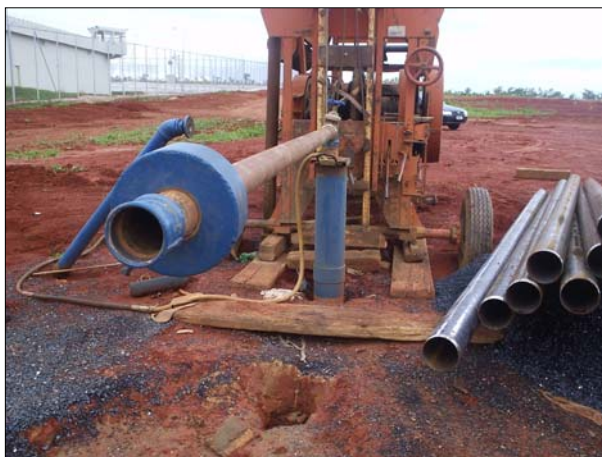
Figura 4.10 – Perfuração do Poço do Cadeão em janeiro de 2007
