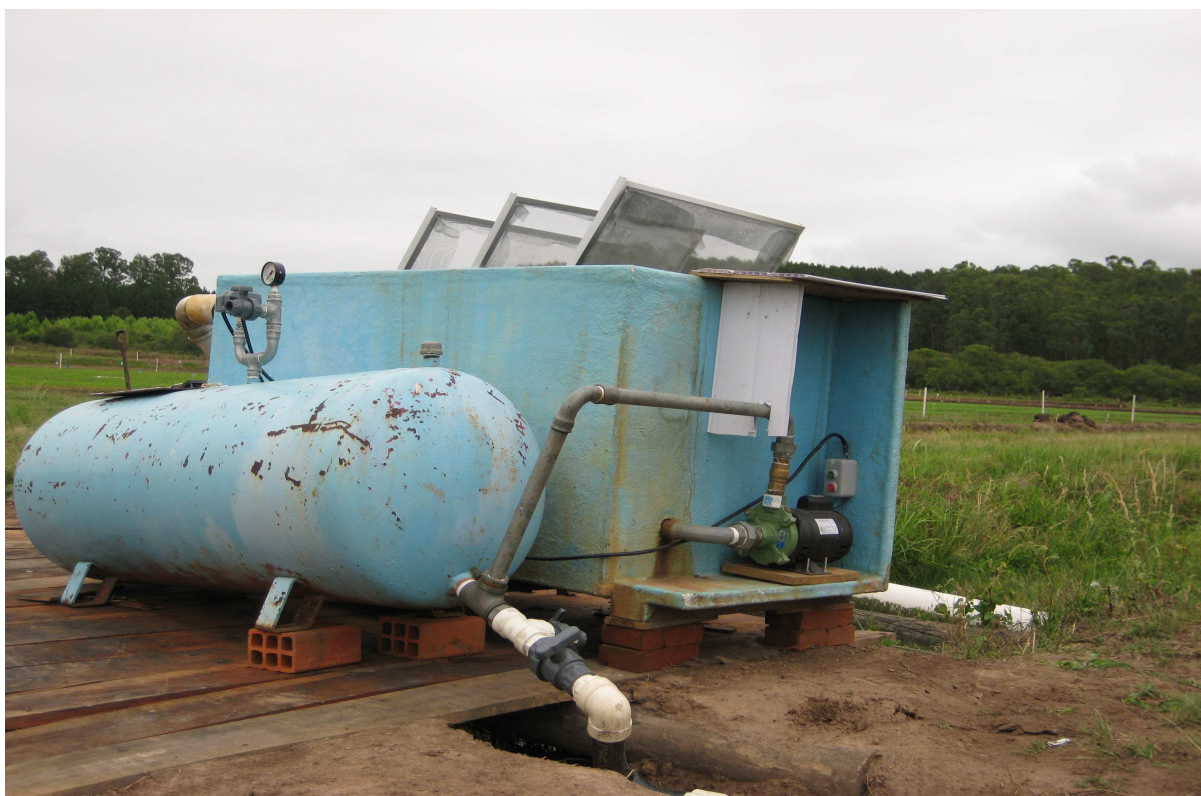
Figura 4. Vista lateral do sistema de armazenamento e pressurização da água de irrigação. Santa Maria, RS. 2009.
