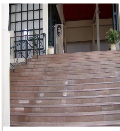
FIGURA VIII – Escadarias do CRP
