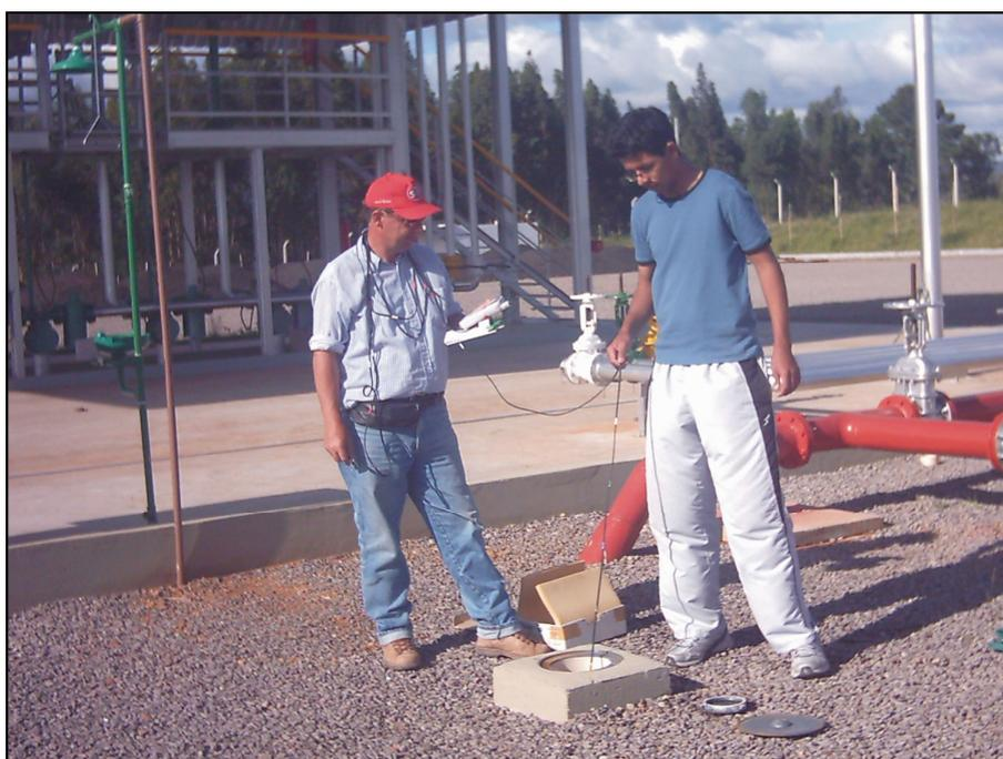
Figura 3.2 – Medição dos parâmetros temperatura da água e O.D.
