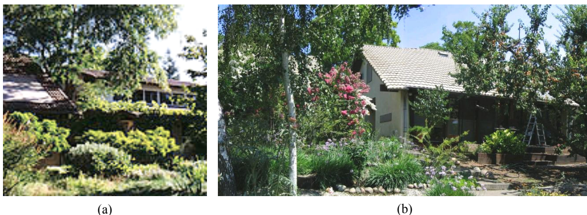
Figura 4.8 – Habitações por trás da arborização – reduz o calor no verão - Village Homes.
