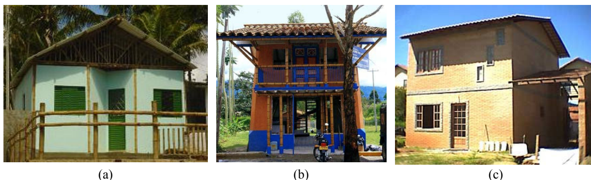
Figura 5.29 – (a) e (b) Casas com paredes e estruturas de bambu; (c) Moradia feita com tijolos de solocimento.
