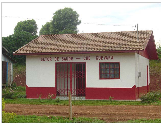
Foto 01: Fachada do posto de saúde Fonte: Arquivo da Cooperunião
