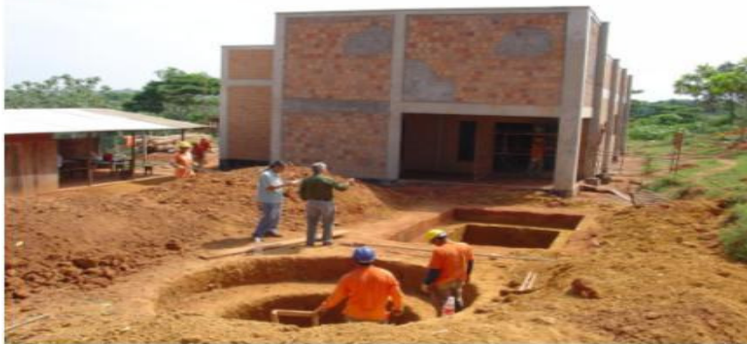
Usina de leite de soja quando em construção em Itacoatiara (AM)
