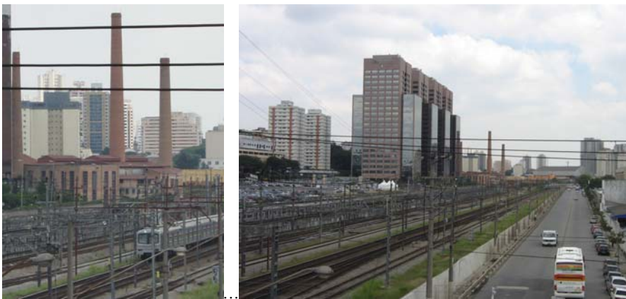
Imagens 39 e 40 – Casa das Caldeiras (a esquerda e ao fundo) Foto: Marcos Boldarini, 2006.
