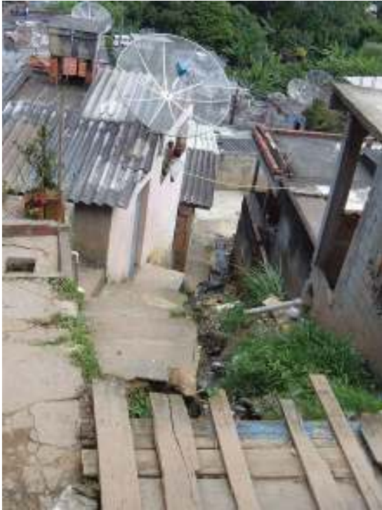
Foto 1: Vista da escadaria, numa cota intermediária. Esgoto despejado a céu aberto e ligações de energia.
