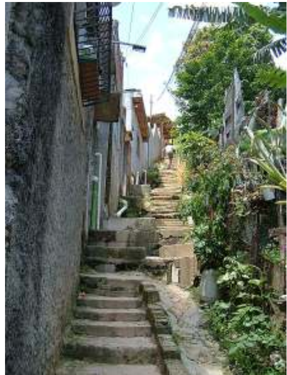
Foto 4: vista da escadaria no meio da ocupação. Esgotos despejados nas laterais da escadaria.
