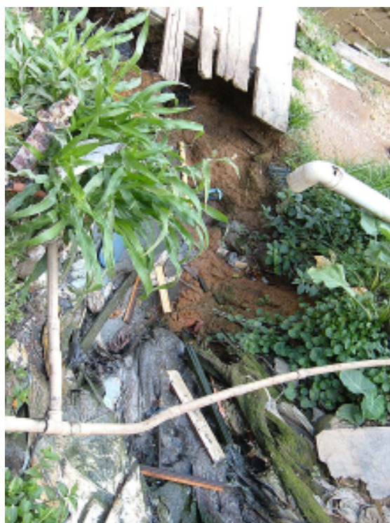
Foto 8: esgoto e lixo lançados na encosta. Ligações de água improvisadas.
