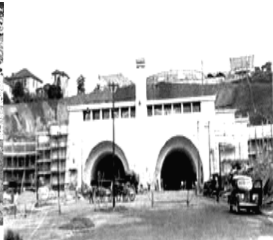
Fig. 9 - Travessia do espigão central pelos 2 túneis da av. 9 de julho. Fonte:Segawa
