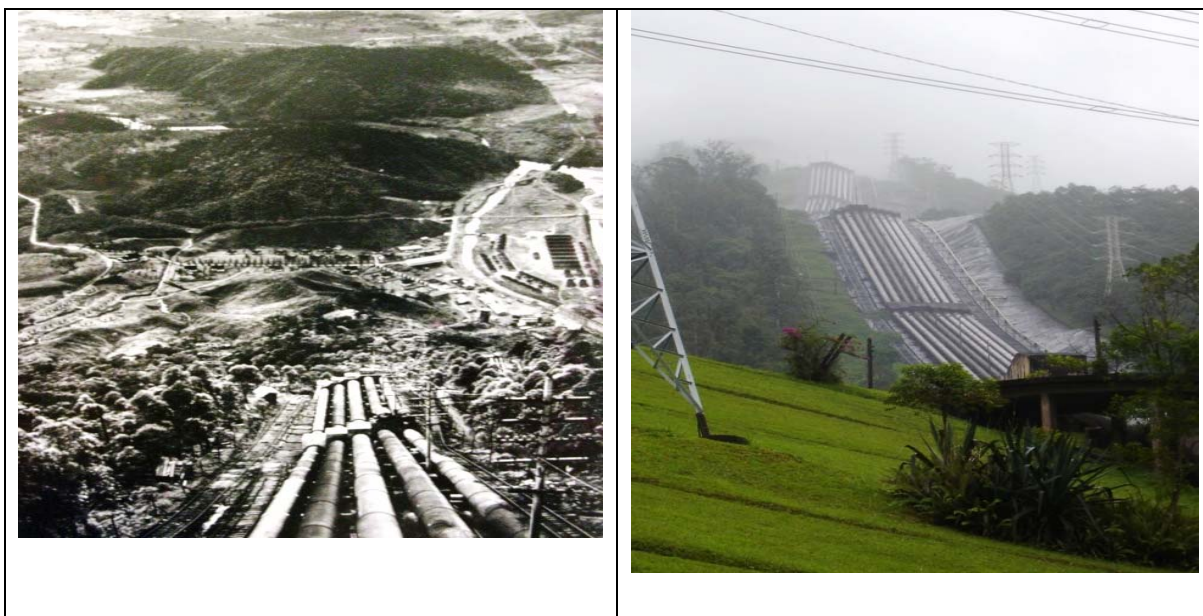
Figura 38 – Usina Henry Borden em direção à Serra do Mar. Fonte:EMAEL/LIGHT
