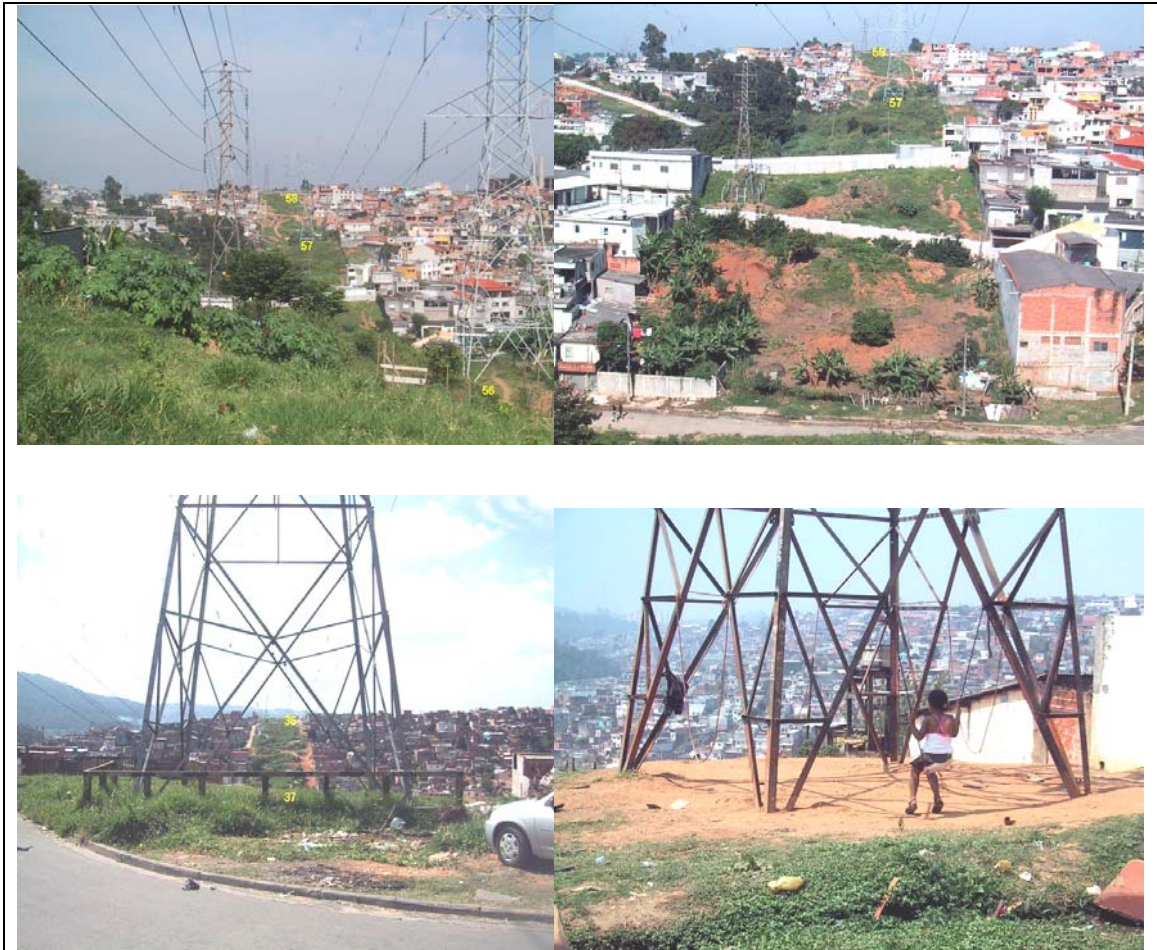
Figura 36 – Exemplos de ocupação nas faixas de Linhas de Transmissão.
