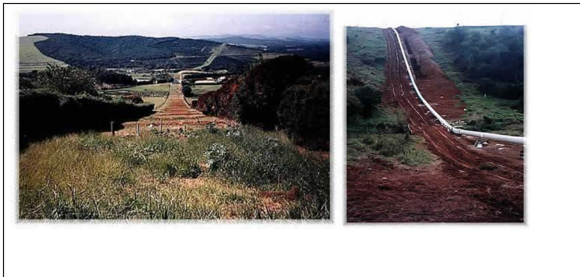
Figura 39 – Implantação de oleoduto e gasoduto.
