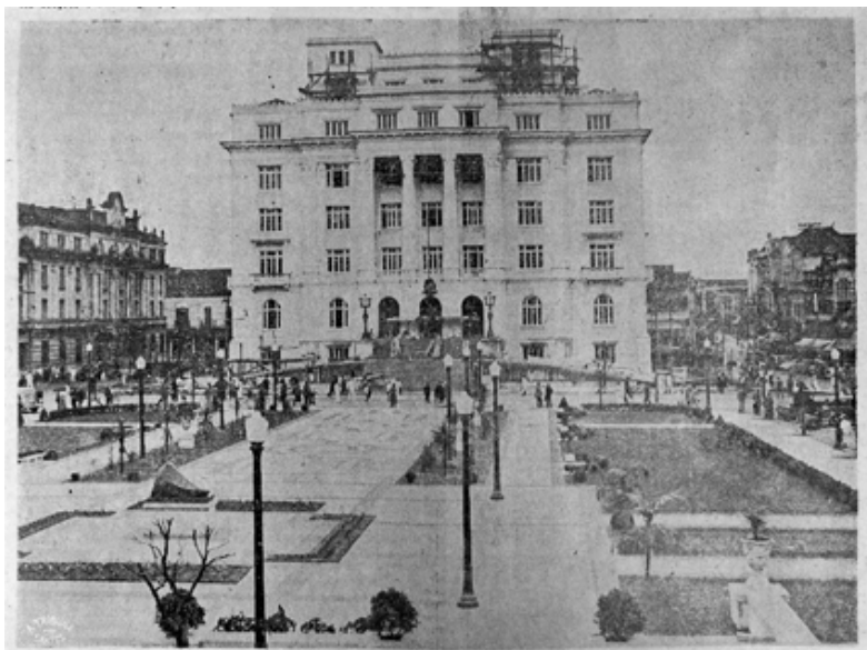
Figura 49 - Foto retrata o novo edifício da prefeitura, recém concluído e que seria inaugurado no dia da publicação da imagem, como comemoração ao centenário da cidade.
