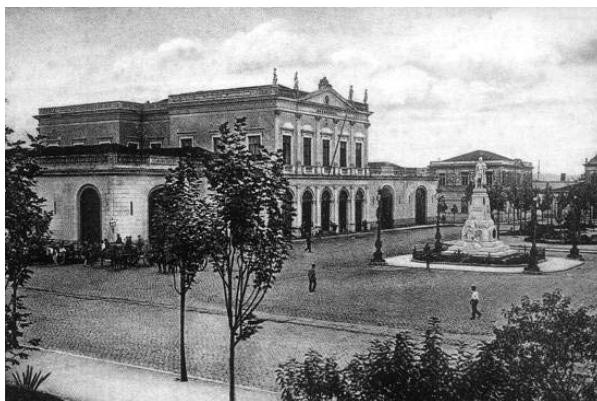
Figura 17 - Praça da República (ca 1908) após a inauguração do Monumento a Braz Cubas. À esquerda, o Prédio da Alfândega e, ao fundo, o local onde existira a Matriz.
