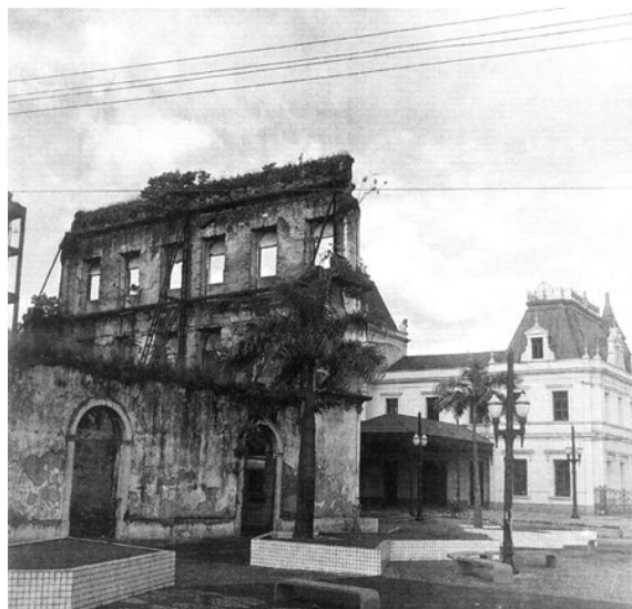
Figura 53 – Fotografia mostra o atual estado do Casarão do Valongo, em ruínas após o incêndio sofrido na década de 80. Disponível em < http://www.novomilenio.inf.br >. Acesso em 23 dez. 2007. Foto enviada por Raimundo Rosa.
