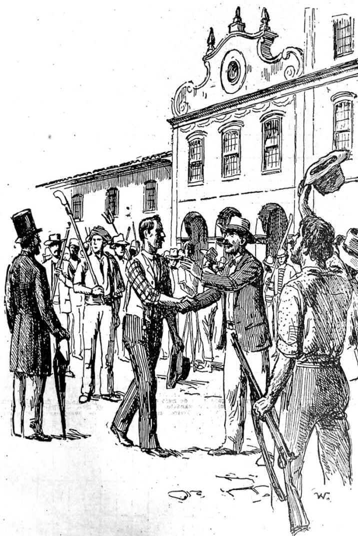
"O encontro com a "tropa" do Valongo deu-se na rua de Santo Antonio, esquina com a rua do Sol, e foi commovente; abraçavam-se em massa e abraçavam-se em abraços, à vista dos commoventes..." Ilustração de JOSÉ WASH RODRIGUES
