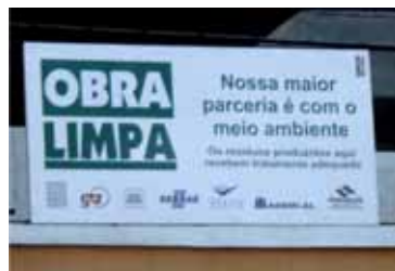
Figura 18: Placa com apelo ambiental na obra de um edifício em Maceió-AL.
