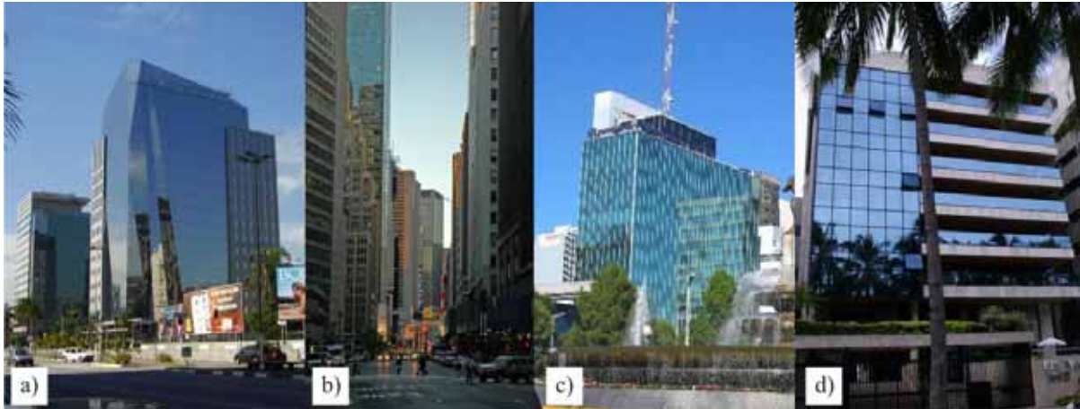
Figura 5: Edifícios com pele de vidro em regiões de climas distintos.
