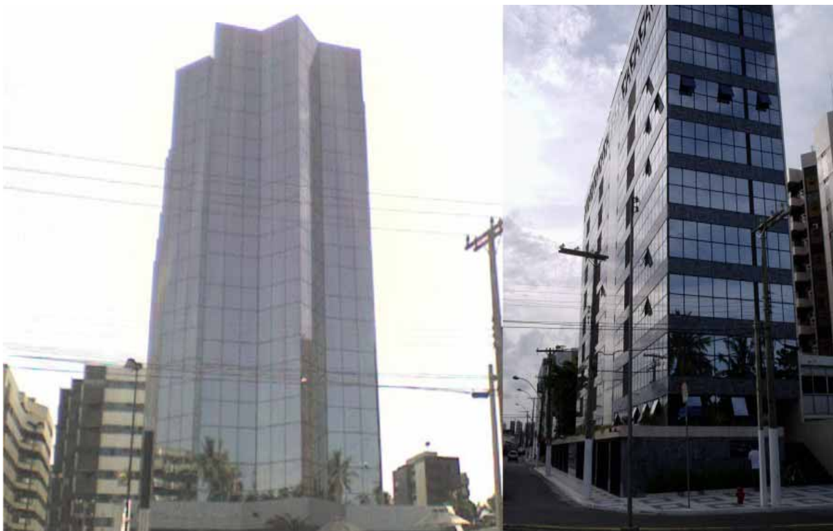
Figura 3: Edifícios com pele de vidro em Maceió/AL, clima quente e úmido.
