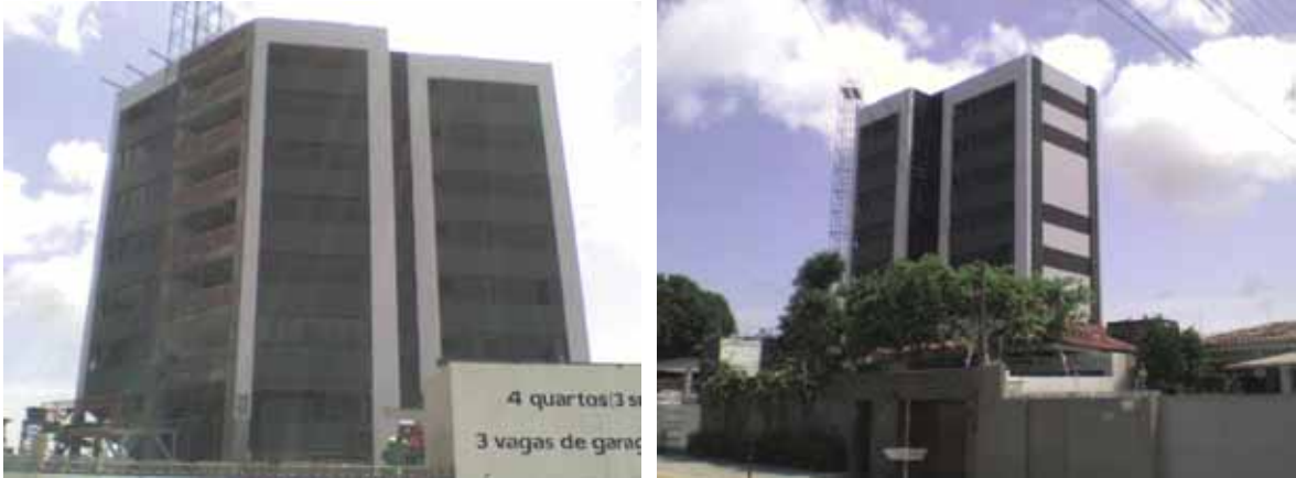
Figura 12: Edifício Caiana, bairro do Farol, Maceió-AL. Fachada com grandes janelas em vidro.
