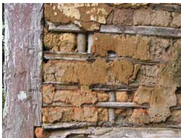
Figura 7: Detalhe de parede em taipa de pau-a-pique
