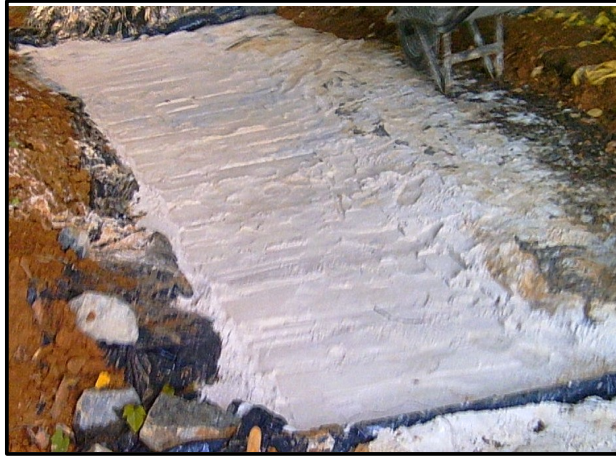
Figura 21. Escavação preenchida com areia seca.
