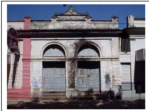
Casa das Linhas antes da demolição – 2005
