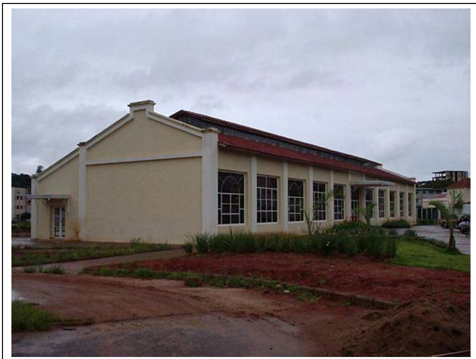
Galpão recuperado, atual Secretaria de Educação. Vista lateral, sentido centro.
