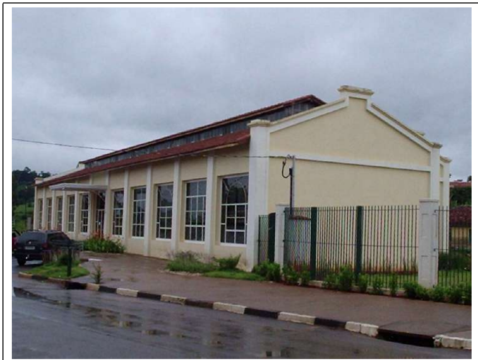
Barracão recuperado (oifinas) atual Sec. de Educação. Vista lateral
