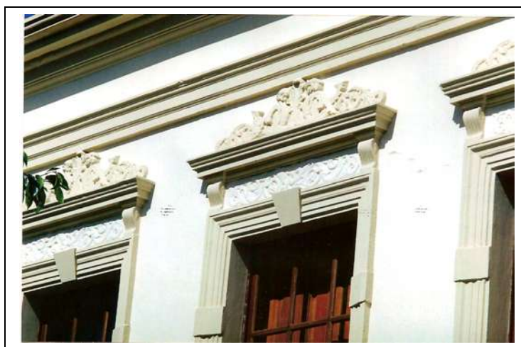
Detalhes das janelas laterais. Fonte Marcos David
