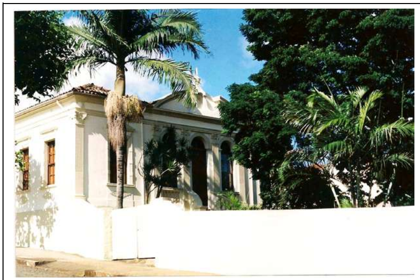
Fachada dos fundos. Fonte Marcos David
