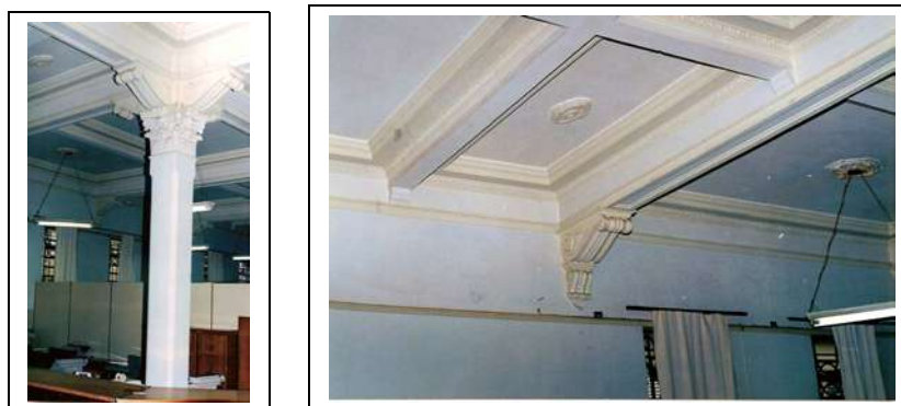
Interior da edificação, com detalhes nas colunas e vigas do teto
