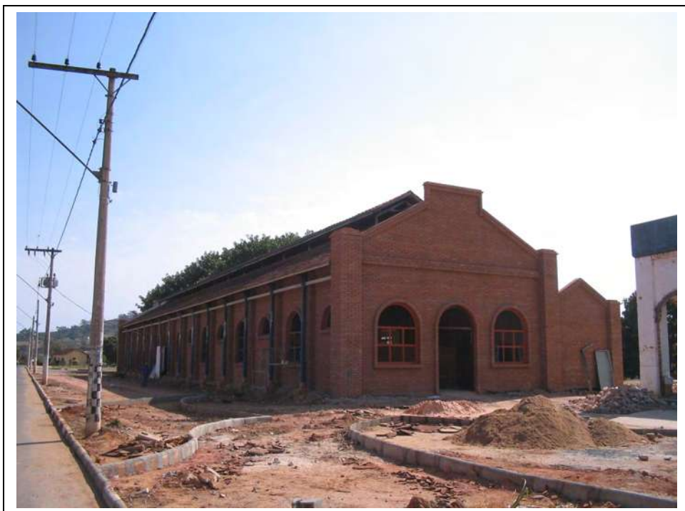
Galpão em recuperação – Divisão de Cultura
