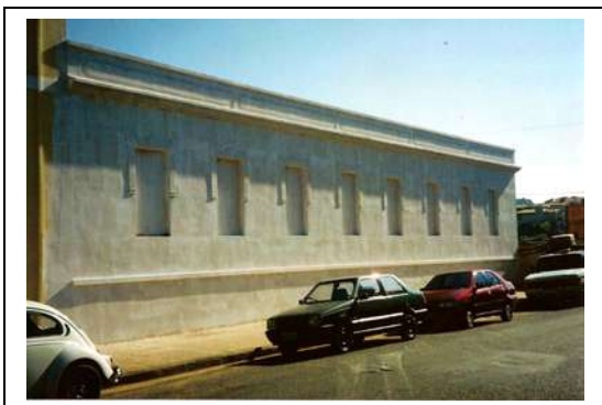
Fachada lateral antes de receber a pintura
