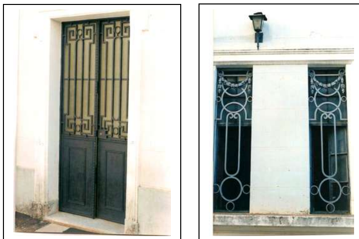
Grade em ferro fundido das janelas
