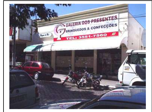
Casa Sayeg depois da reforma Foto do autor 2007
