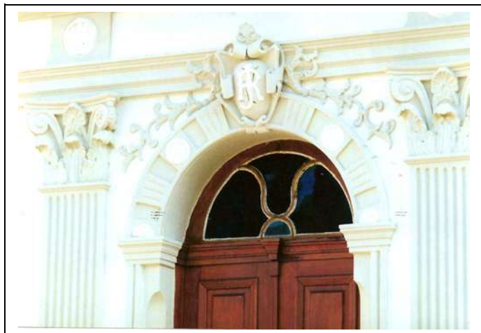
Porta de acesso em arco pleno
