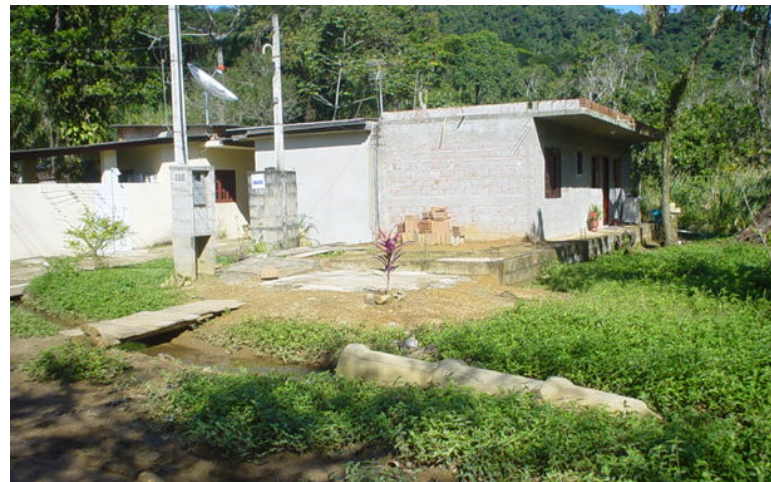
Figura 3.20 - Rua Del Rey– esgoto “in natura”. Fonte: arquivo GPDUHS, jun/04.
