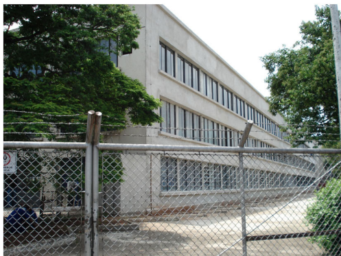
Edificação em reforma - FERCOI
