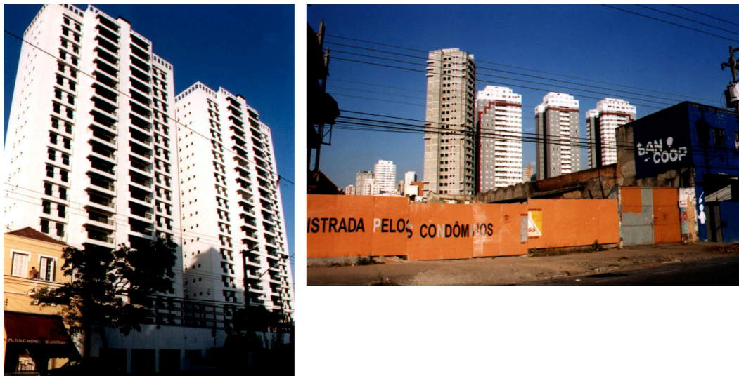
Figura 3.1 Fotos de Empreendimentos Imobiliários região da Mooca (2002)
