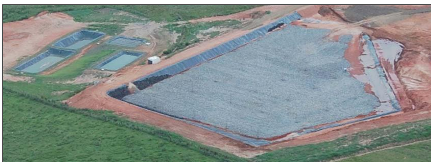
Figura 54 – Área do aterro Sanitário em fase de construção Fonte: Salamoni, Rafael. 2008.
