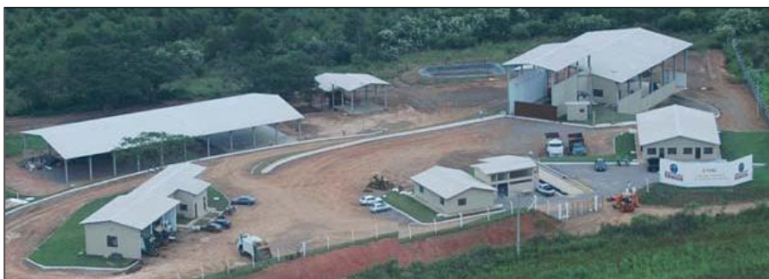
Figura 53- Instalações da Central Fonte: Salamoni, Rafael. 2008.
