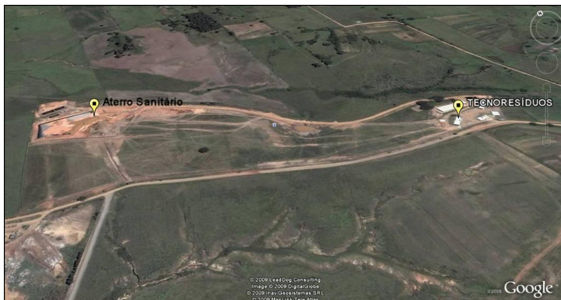
Figura 52- Central de Regional de Tratamento e Destinação de Resíduos Sólidos Urbanos. Fonte: Google Earth, 2008.
