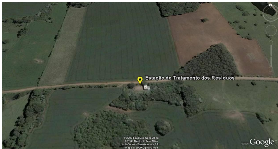
Figura 58- Estação de tratamento dos resíduos.
