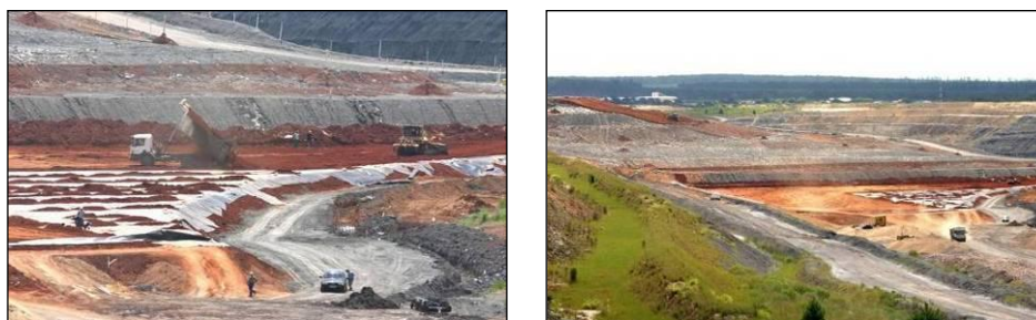
Figura 51- Central de Resíduos do Recreio.
