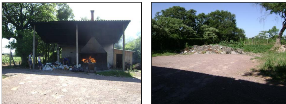
Figura 60- Instalações da Estação de Tratamento dos resíduos.
