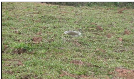
Figura 14- Dreno do gás.
