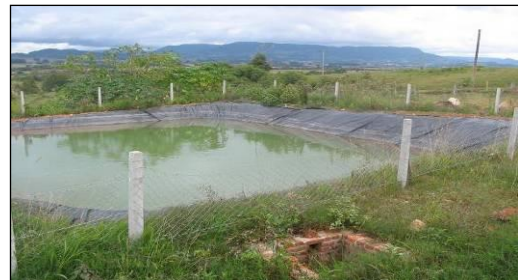
Figura 13- Tanque de percolado.
