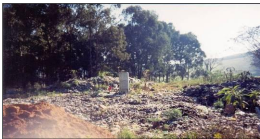
Figura 18- Dreno do gás.
