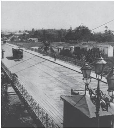
[7a] Viaduto do Chá, por volta do ano de 1900, com o pavimento em tábuas sobre vigas de madeira apoiadas diretamente na estrutura metálica.
