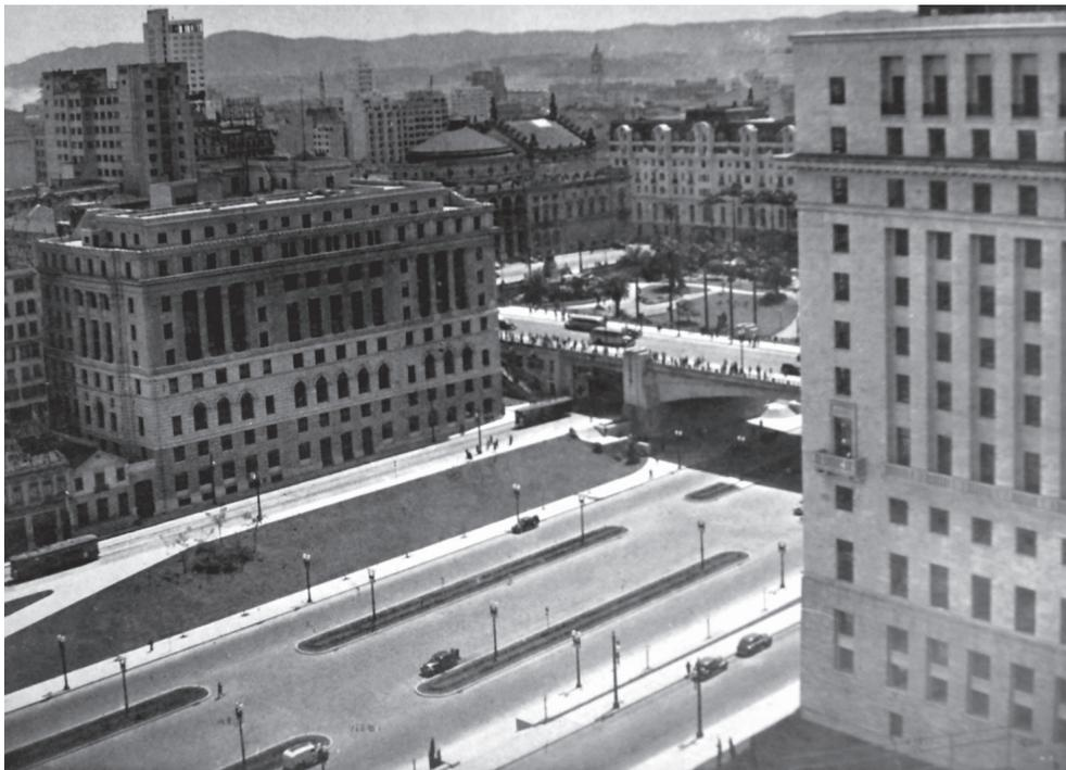
[19] Vista do Vale do Anhangabaú, onde o jardim pitoresco fora substituído por uma via de trânsito rápido, interligando as avenidas Nove de Julho e Tiradentes, fechando um tramo do Sistema y. O asfalto fora o pavimento escolhido como o mais adequado para comportar o fluxo de veículos e a rápida expansão da cidade, além de permitir uma maior velocidade na pavimentação graças ao aparelhamento da prefeitura para realizar estes serviços.
