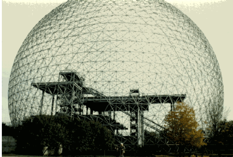
imagem. 02-09 Detalhe da Estrutura
