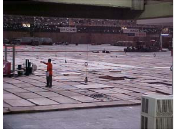
imagem 2-58 Feito isso todo a base de piso(pallets) é colocada
