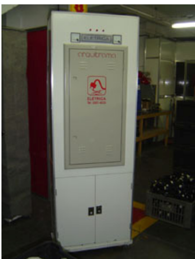
imagem 2-29..... Locais de armazenamento Empresa Arquitrama
