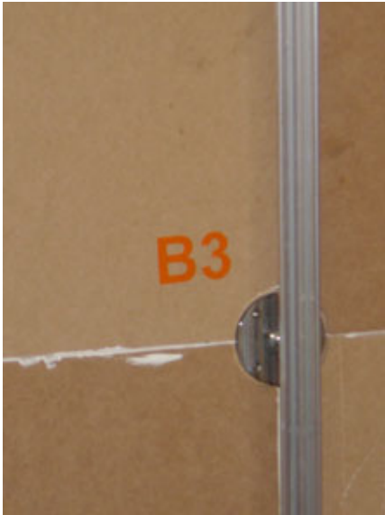
imagem 2-45..... Galpão de pré-Montagem Empresa Arquitrama
