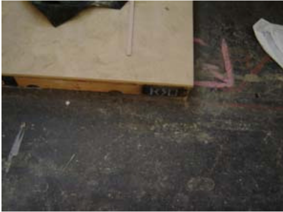
imagem 2-57 Primeiro o piso segue a orientação da marcação
