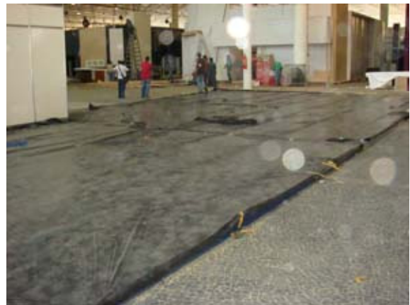
imagem 2-60 piso acabado, é piso protegido por lona preta
