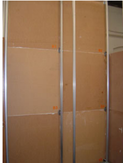
imagem 2-46 Galpão de pré-Montagem Empresa Arquitrama
