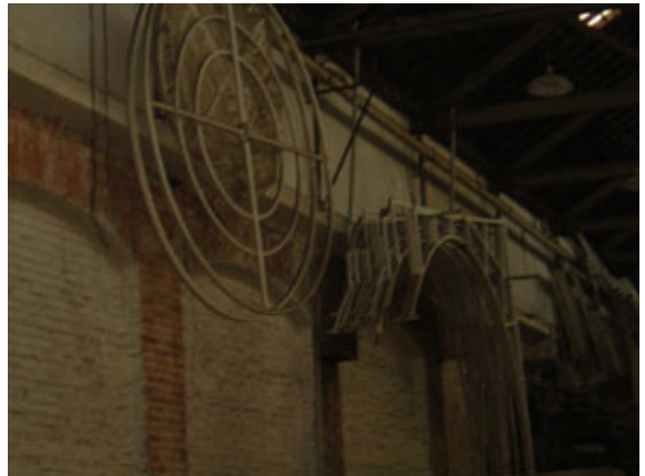
imagem 2-6 Galpões e oficinas Empresa Arquitrama
