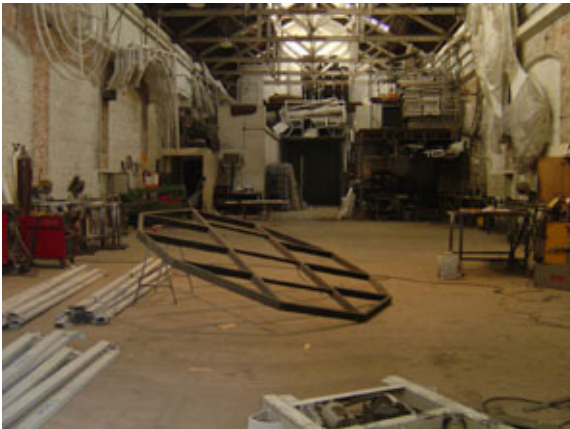
imagem 2-5 Galpões e oficinas Empresa Arquitrama
