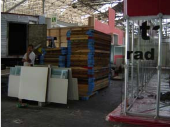
imagem 2-53 Material retirado do caminhão para montagem
