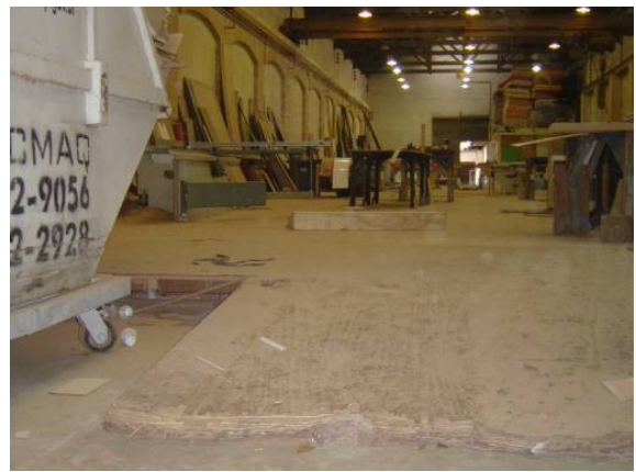
imagem 2-2 Galpões e oficinas Empresa Arquitrama
