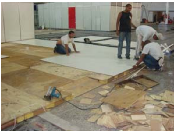
imagem 2-59 Pallets colocados é hora dos acabamentos
