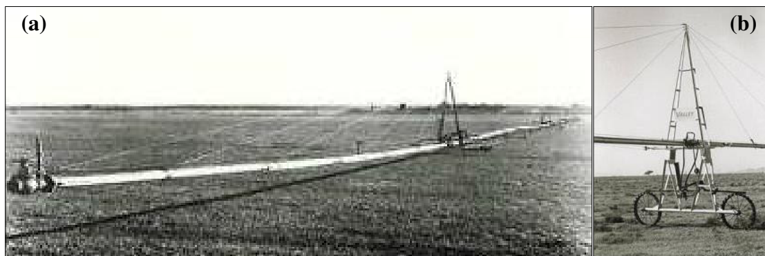
Figura 1. Protótipo do sistema de irrigação tipo pivô central (1a) com detalhe da torre de sustentação da linha (1b).
