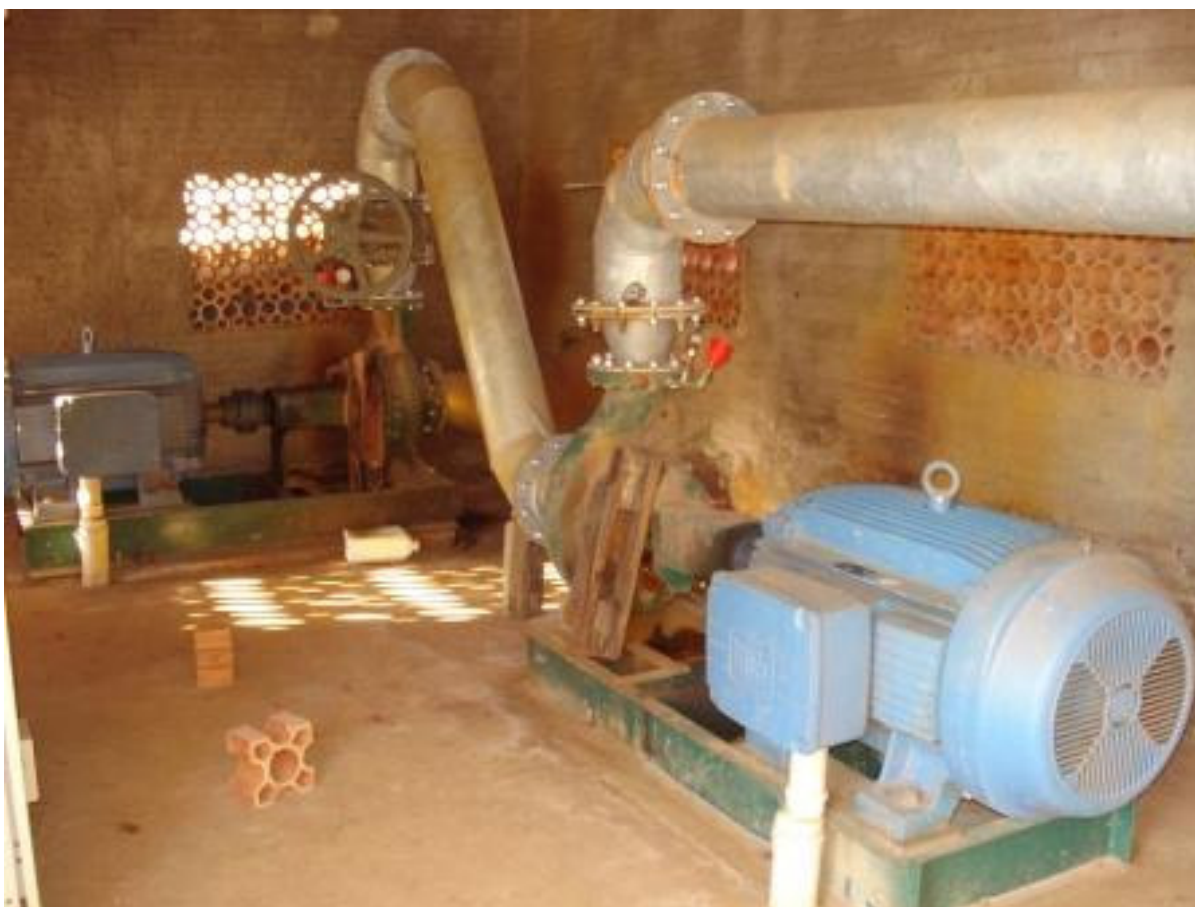
Figura 8. Sistema de bombeamento com associação de bombas em série.
