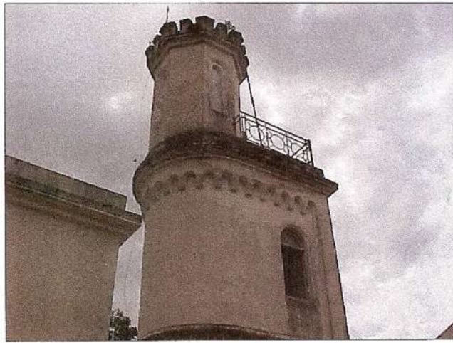
VISTA EXTERNA DA TORRE (foto do autor - 2002)
