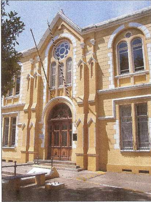
DETALHE DA PORTA DE ACESSO - 2005 (foto do próprio autor)
