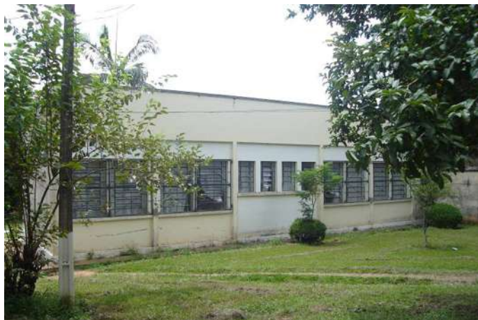
Ilustração 202 – Vista da fachada principal do edifício (foto do autor – 2007).
