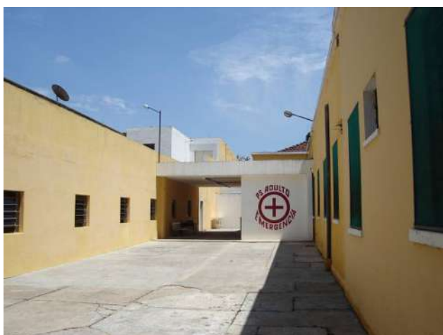
Ilustração 144, 144 e 144 – Vistas das ampliações realizadas para a adaptação do Hospital de Clínicas de Franco da Rocha. (foto do autor – 2006).
