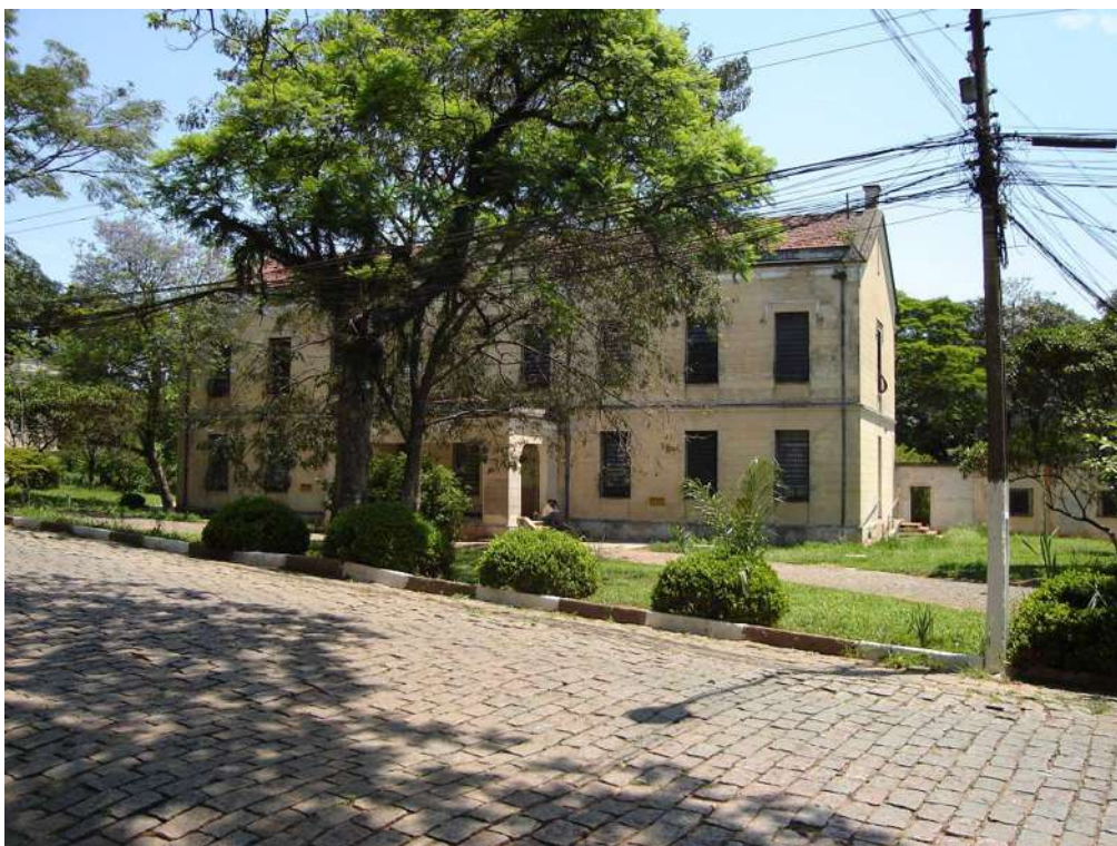
Ilustração 158 - Foto da fachada frontal do serviço (foto do autor – 2007)
