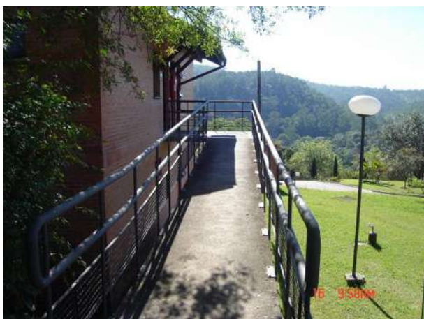
Ilustração 233 - Já nas construções novas o acesso por rampa é garantido com corredores com a inclinação adequada para a cadeira e maca (foto do autor – 2007)
