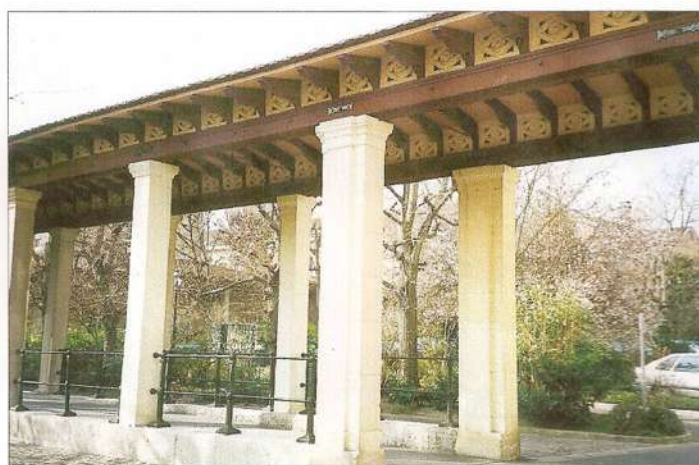
FOTO 07 - GALERIA DE CIRCULAÇÃO
