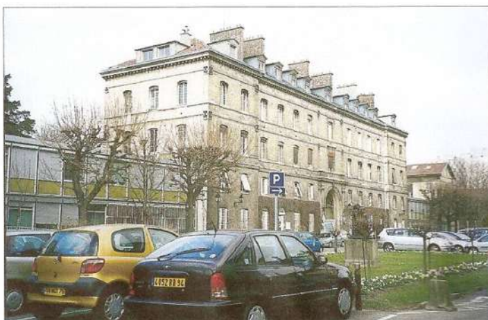
FOTO 03 - FACHADA FRONTAL DO PAVILHÃO ADMINISTRATIVO
