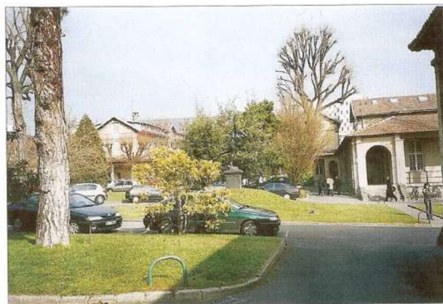
FOTO 09 - VISÃO GERAL DAS GALERIAS DE CIRCULAÇÃO
