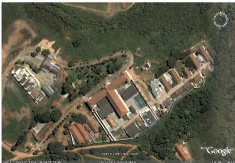
Ilustração 36 – Manicômio Judiciário, atual Colônia de progressão de pena – sistema penitenciário (Google Earth).
