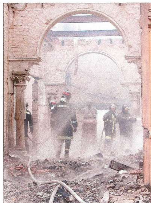
VISTA DO HALL DE DISTRIBUIÇÃO APÓS INCÊNDIO (foto do próprio autor)
