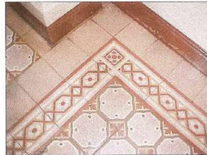
DETALHE DO LADRILHO HIDRÁULICO (cópia cedida pela Arq. Gina Dartora)
