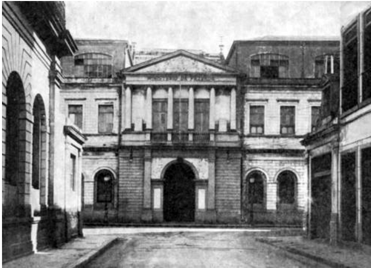
Ilustração 102 – foto da fachada principal da escola de Belas Artes do Rio de Janeiro, projeto de Grandjean de Montigny –
