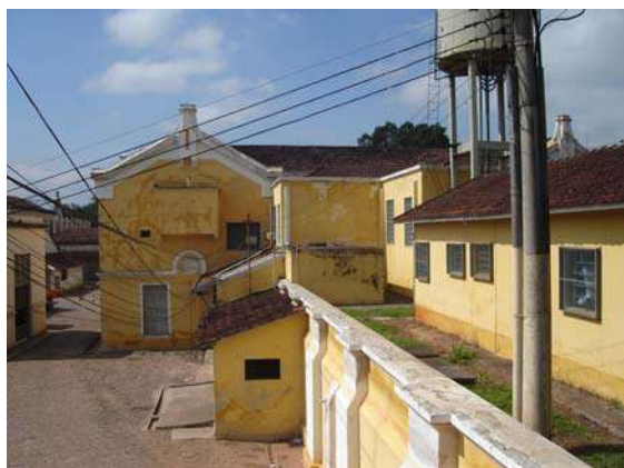
Ilustração 189 – Vista na lateral direita do prédio do conforto médico (foto do autor – 2007).
