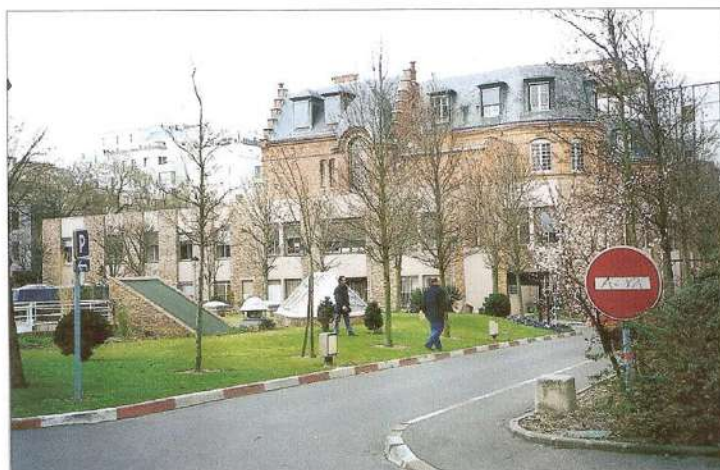
FOTO 08 - FACHADA LATERAL DO CENTRO CIRÚRGICO
