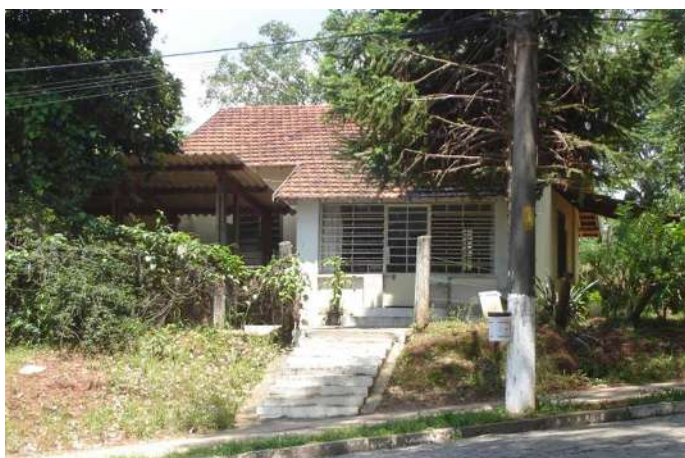
Ilustração 200 – Vista da entrada principal da construção (foto do autor – 2007).
