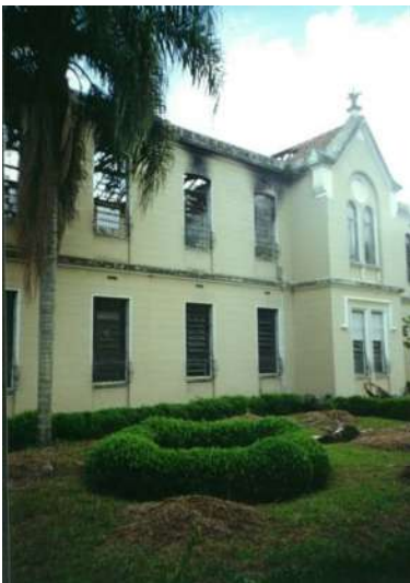
Ilustração 72 - Foto do incêndio que atingiu o Pavilhão Masculino de Agudos (foto do Autor – 2000)
