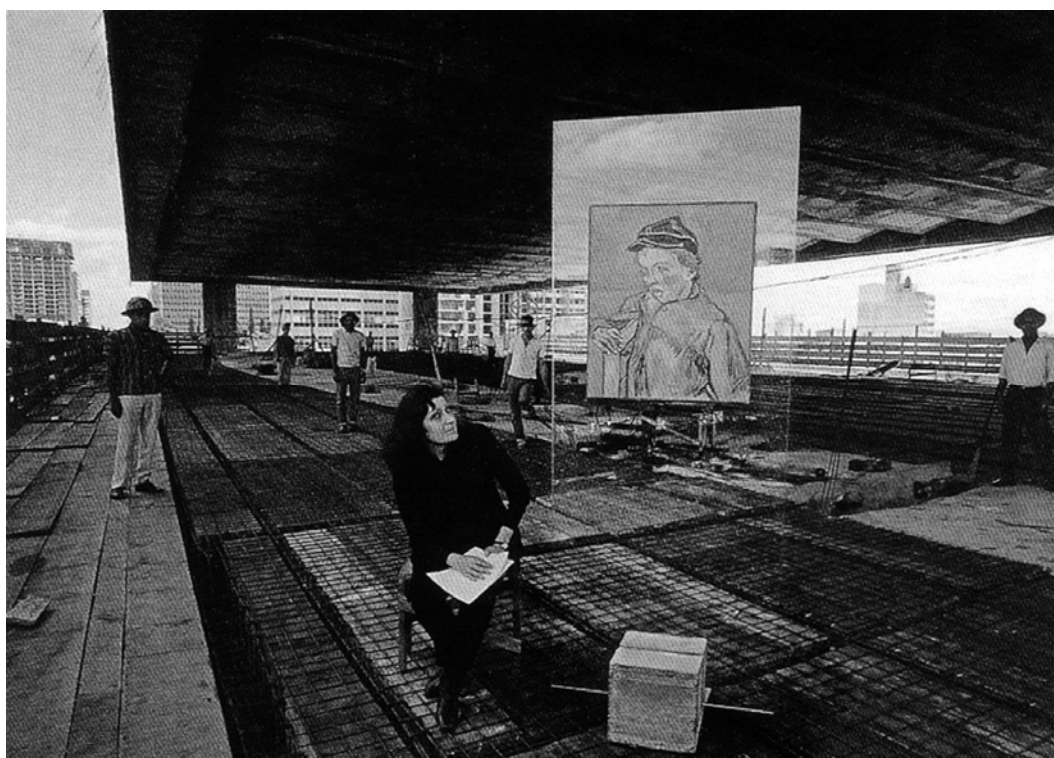
Fig. 148. Canteiro de obras do MASP.
