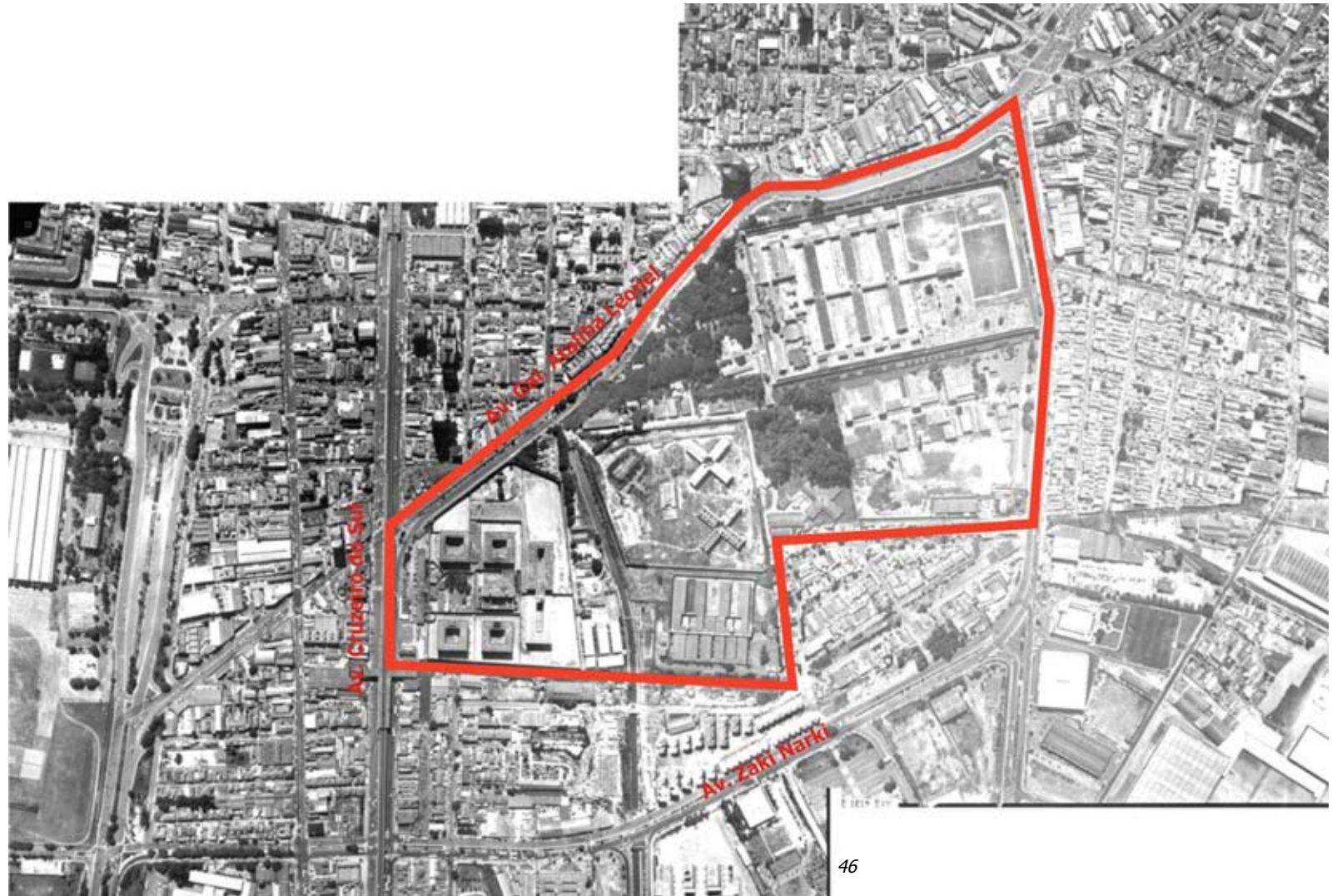
46. Foto Aérea do Complexo Carandiru na época do concurso (Material de base do concurso).
