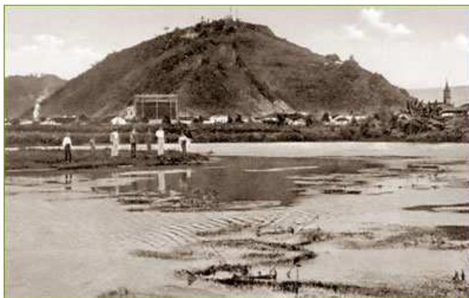
Figura 6: A zona do Outeirinhos, entre Macuco e Vila Mathias – alagadiços antes das drenagens. (Coleção João Gerodetti / fonte: Prefeitura Municipal de Santos)
