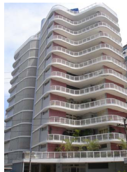
Figura 78: Foto do edifício Itamaraty, atualmente (tirada em 09/03/2008). Observa-se o fechamento das varandas em tela metálica, originalmente composto por combogós de porcelana. A reforma não comprometeu a leitura do conjunto arquitetônico. Fonte: foto do autor.
