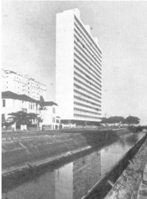
Figura 72: Foto do Edifício Porto Fino em 1964. No primeiro plano o canal número um ou Avenida Pinheiro Machado, ao fundo a orla da praia. Foto de J. Xavier. Fonte: Revista Acrópole nº 310, p.39.
