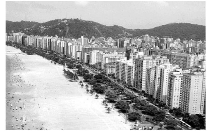
Figura 18: Visual da orla da praia (entre os canais 5 e 6) e o predomínio dos edifícios. Foto de Anderson Bianchi. Fonte: Diário Oficial de Santos, 19/06/2003.
