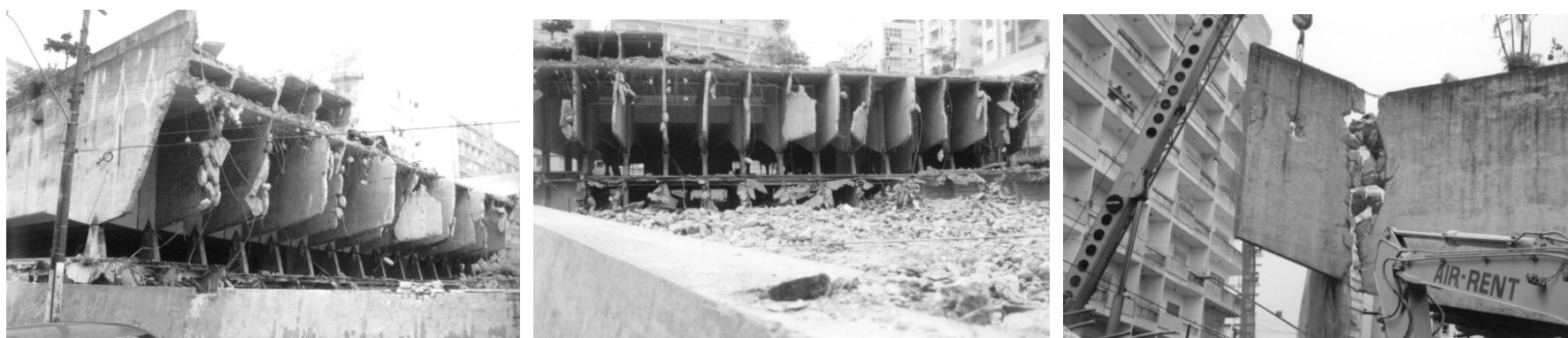
Figuras 110, 111, 112: Fotos da demolição do Clube XV, tiradas em 2001. Foto do autor.
