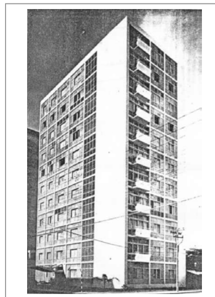
Figura 96: Foto do edifício Caeté na década de 50. Fonte: ALVES, Jaqueline, 2000, p. 44.
