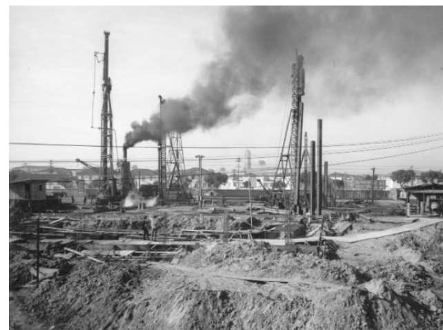
Figura 132 e 133: Execução das fundações, em 1969. Foto de J. Moscardi. Fonte: Faculdade de Arquitetura de Santos.
