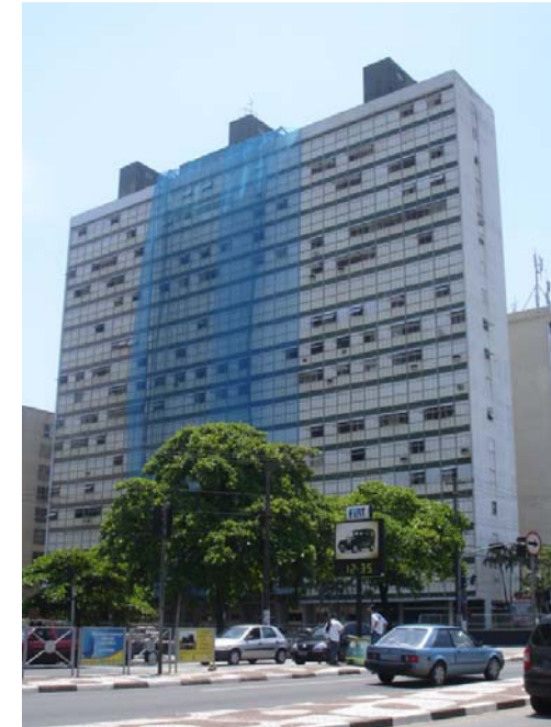
Figura 73: Foto do Edifício Porto Fino a partir da orla da praia, em 02/02/2008. Foto do autor
