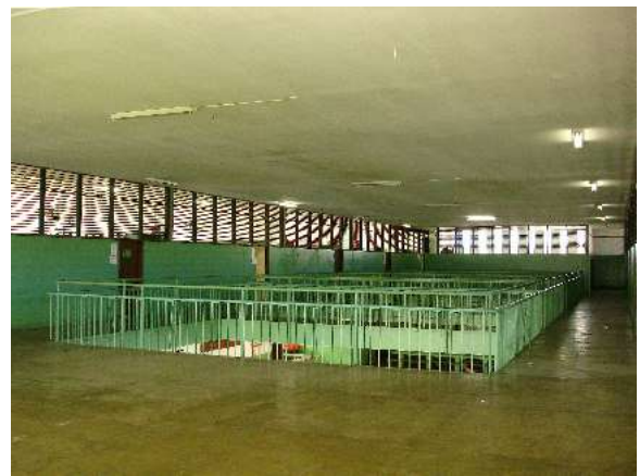
Fig. 180: Maurício tuck Schneider, Grupo Escolar de Vila Pae Cará, Vicente de Carvalho, Guarujá: galpão, acesso à salas de aulas.
