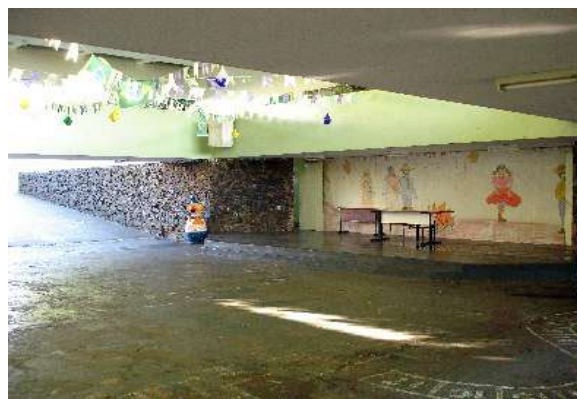
Fig. 209: José Maria Gandolfi, Grupo Escolar de Guapiçu, Guapiçu: galpão.
