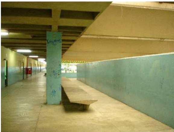
Fig. 296: Vilanova Artigas, Ginásio Estadual de Utinga, Santo André: circulação das salas de aula.
