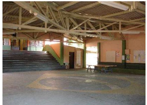
Fig. 105: João Xavier, Grupo Escolar Salesópolis, Salesópolis: galpão e desnível da administração.
