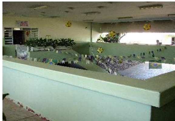
Fig. 207: José Maria Gandolfi, Grupo Escolar de Guapiçu, Guapiçu: galpão e vazio central.
