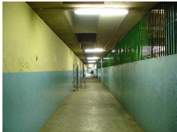
Fig. 299: Vilanova Artigas, Ginásio Estadual de Utinga, Santo André: circulação entre salas de aula e galpão.
