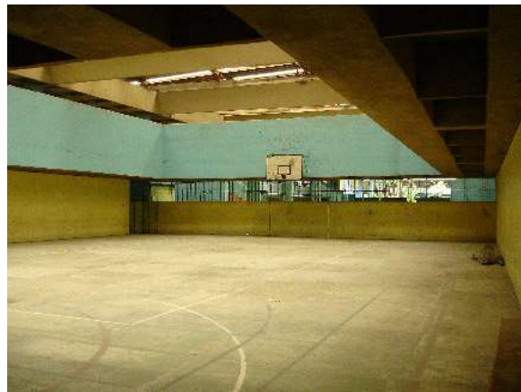
Fig. 297: Vilanova Artigas, Ginásio Estadual de Utinga, Santo André: galpão.
