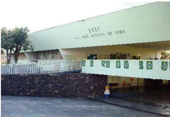
Fig. 206: José Maria Gandolfi, Grupo Escolar de Guapiçu, Guapiçu: fachada.
