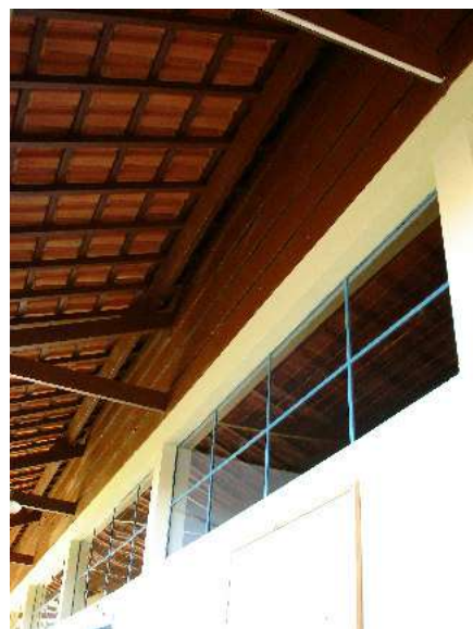
Fig. 9: Carlos B. Millan e Galiano Ciampaglia, Grupo Escolar de Guedes, Jaguariúna: detalhe das esquadrias e cobertura junto à circulação do pavilhão de salas de aula.
