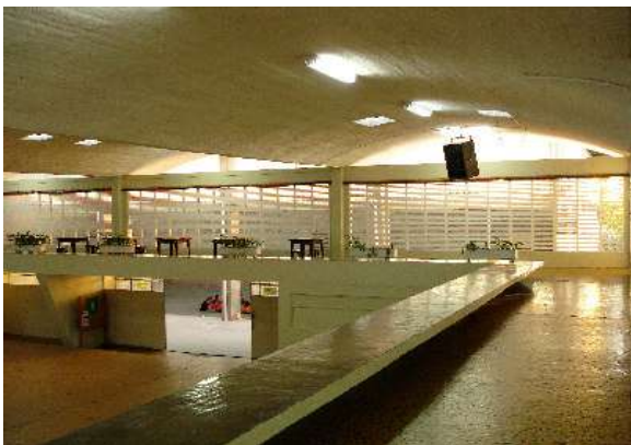
Fig. 218: Luiz Forte Neto, Ginásio Vila Arens, Jundiáí: circulação e vazio do galpão.
