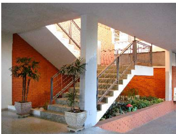
Fig. 88: Plínio Croce e Roberto Aflalo, Grupo Escolar de Pompéia: escada.
