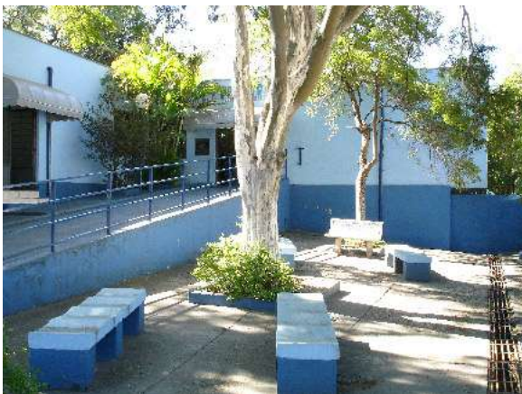
Fig. 194: José Maria Gandolfi, Grupo Escolar de Pedreira, Pedreira: fachada.
