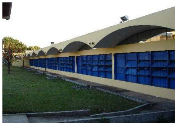
Fig. 221: Luiz Forte Neto, Ginásio Vila Arens, Jundiáí: fachada das salas de aula.
