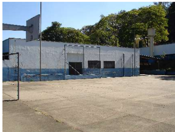
Fig. 195: José Maria Gandolfi, Grupo Escolar de Pedreira, Pedreira: fachada.
