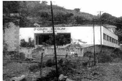
Fig. 193: José M. Gandolfi, Grupo Escolar de Pedreira, Pedreira. (Proc. IP 445323 de 08/08/1961)
