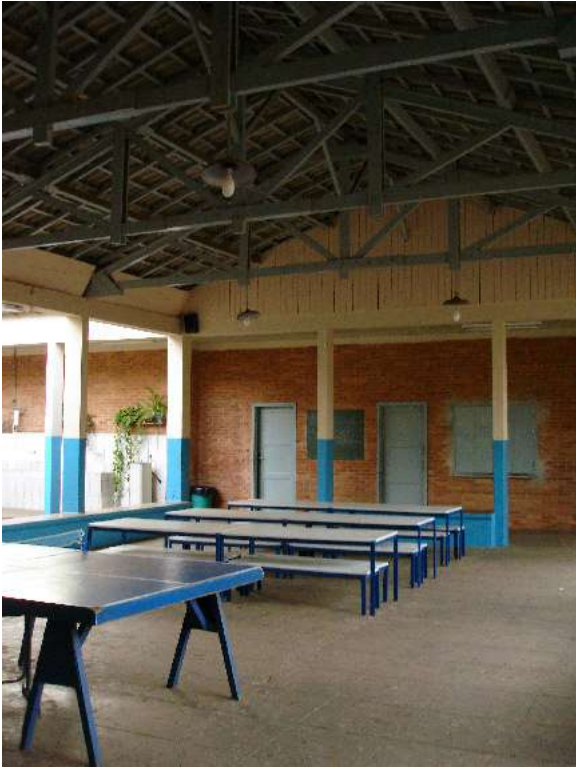
Fig. 33: Jacob M. Ruchti, Grupo Escolar, Martin Francisco, Mogi Mirim: galpão.
