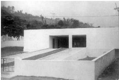
Fig. 191: José M. Gandolfi, Grupo Escolar de Pedreira, Pedreira. (Proc. IP 445323 de 08/08/1961)
