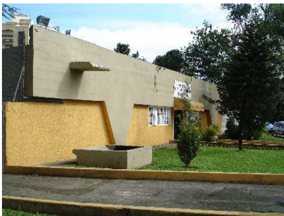
Fig. 230: Abrahão Sanovicz, Ginásio Estadual em Santos-Ponta da Praia, Santos: fachada.
