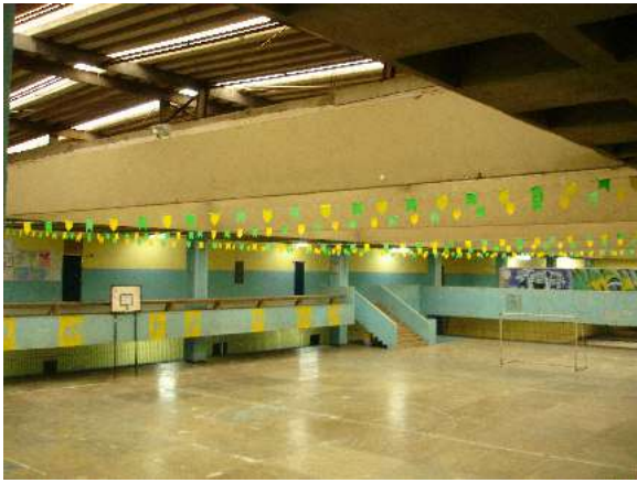
Fig. 294: Vilanova Artigas, Ginásio Estadual de Utinga, Santo André: galpão.
