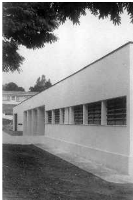
Fig. 192: José M. Gandolfi, Grupo Escolar de Pedreira, Pedreira. (Proc. IP 445323 de 08/08/1961)
