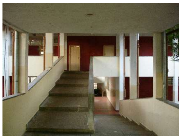
Fig. 51: Oswaldo A. Bratke, Grupo Escolar Vila Lemos, Campinas: escadas de acesso às salas de aula.
