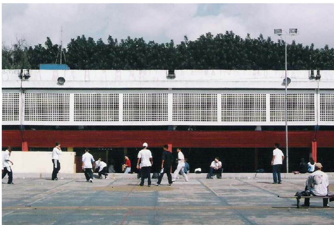
Fig. 155: Vilanova Artigas, Ginásio Estadual Conselheiro Crispiniano, Guarulhos: fachada.
