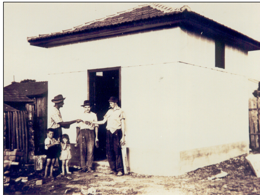
Figura 52 – Primeira construção em alvenaria, na rua Carlos Gomes – é possível notar que acima do nível do topo da porta as paredes segem executadas em madeira - 1954, Fonte: Centro cultural Gilberto Mayer de Cascavel.
