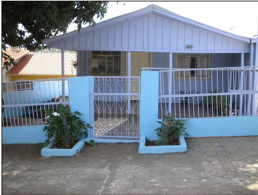
Figura 65 – Modulação das tábuas a cada 23cm, Toledo julho de 2007. – Fonte: foto do autor
