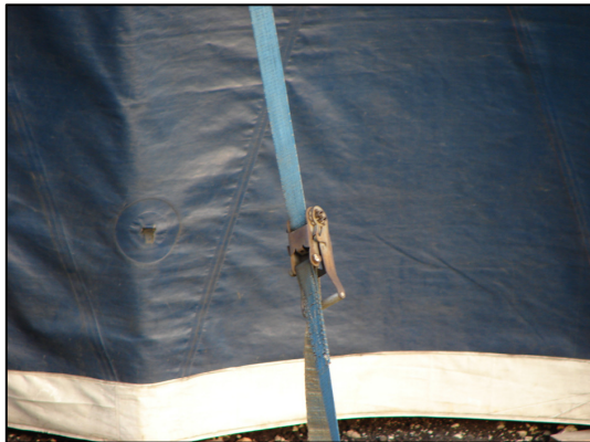
Figura 34 - Sistema tensivo dos tirantes, foto circo Spacial, São Paulo 2007. - Fonte: Foto do autor
