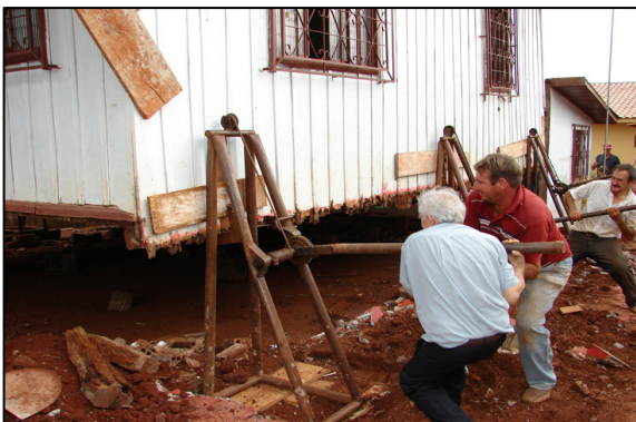
Figura 68 – Içamento da casa, Cascavel, julho 2007. Fonte: foto do autor.
