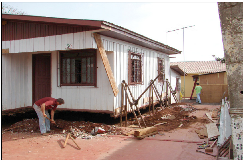
Figura 69 – Içamento da casa, Cascavel, julho 2007. Fonte: foto do autor.
