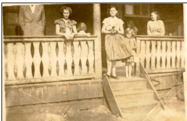
Figura 66 – Escada de madeira com espelho e cremalheiras laterais, 1952. - Fonte: Centro cultural Gilberto Mayer de Cascavel.
