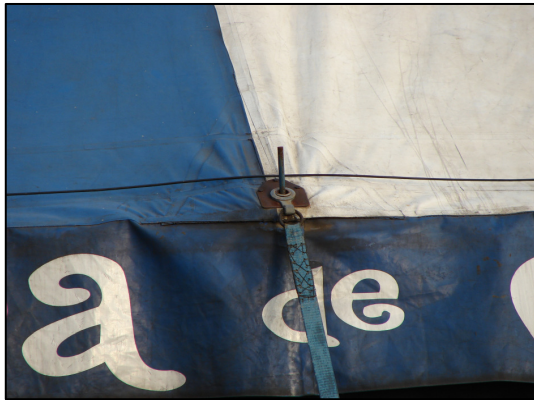
Figura 33 - Modelo de fixação dos tirantes ao pau de roda. - Fonte: Foto do autor, circo Spacial, São Paulo 2007.
