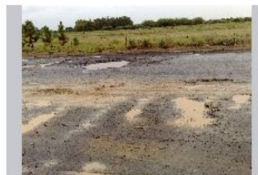
FOTO RS 101 - ESTRADA DO INFERNO KM 145 (PRÓXIMO)
