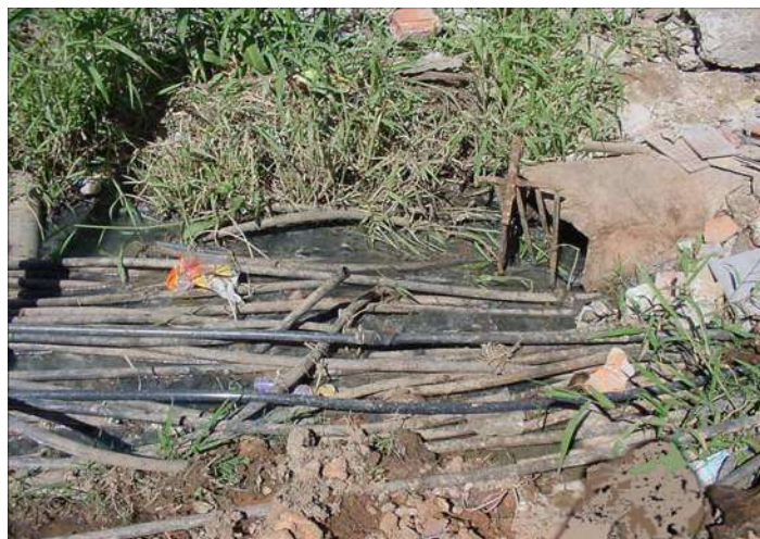
Fig. 41 - Mangueiras de ligação clandestina em meio ao esgoto no Jardim Pantanal, situação comum em realidades urbanas precárias, como a do loteamento Colinas, descrito. Fonte: Luiz Lemos, Marzeni Silva e Robson Costa, Adequação da Ocupação Humana no Jardim Pantanal . Apresentação de trabalho da Faculdade de Saúde Pública - USP.
