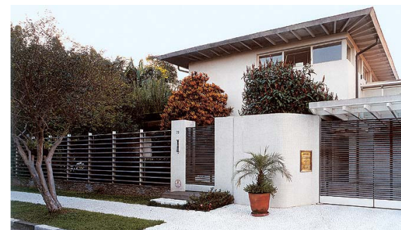
Casa na Rua Sofia projetada por Oswaldo Bratke em 1945 e reformada por Mauro Munhoz em 2002
