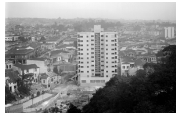
Edifício Columbus, projeto de Rino Levi Fonte: http://www.vitruvius.com.br/arquitextos
