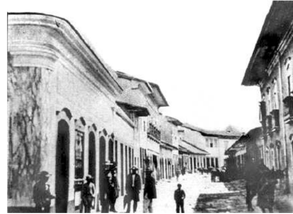
São Paulo em meados do século XIX: primeiras alterações nas fachadas com o objetivo de modernizar a “velha” taipa de pilão – Rua da Quitanda Fonte: http://www.prodham.sp.gov.br/dph
