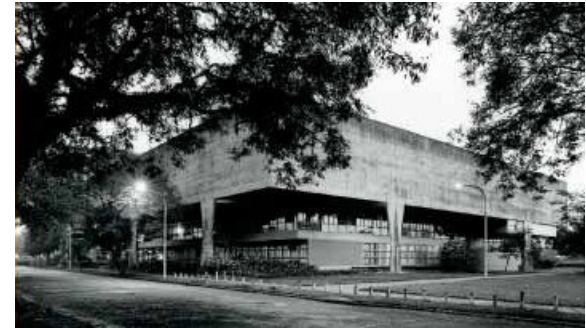
Edifício da FAUUSP, projetado por Vilanova Artigas Fonte: http://www.institutotomieohtake.org.br
