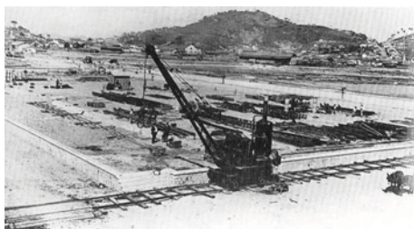
Imagens da construção do cais e do aterro da Gamboa fonte CODERJ
