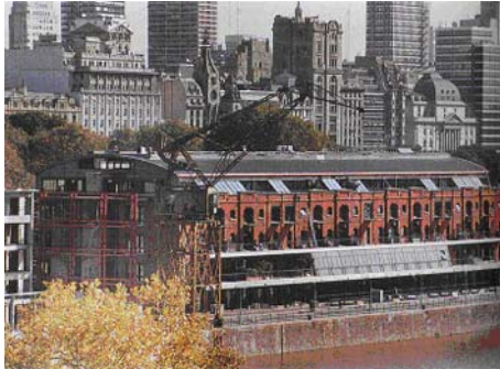
fig.111 Galpão reformado. VARAS, 1997
