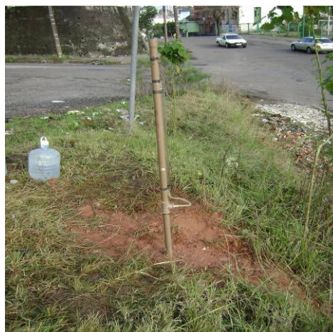
Figura 3.2 – Piezômetro instalado no campo.
