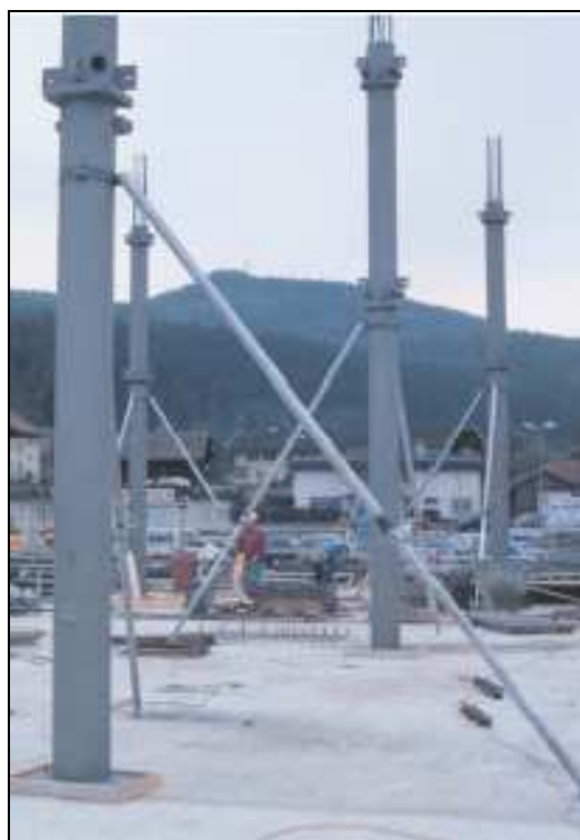
Figura 21 – Contraventamento realizado em um pilar misto – CAMPOS (2006)
