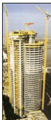
durante a construção
