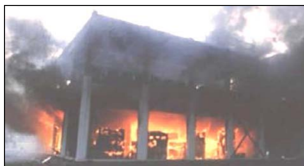
(b) edificação durante o incêndio
