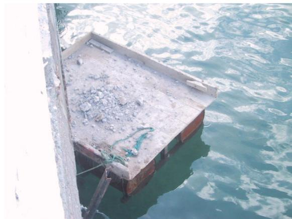
Figura 57 – Obra B2: Balsa para a Captação dos Resíduos
