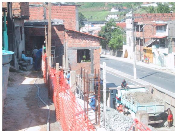
Figura 25 – Obra A2: Confeção Alvenaria Contenção
