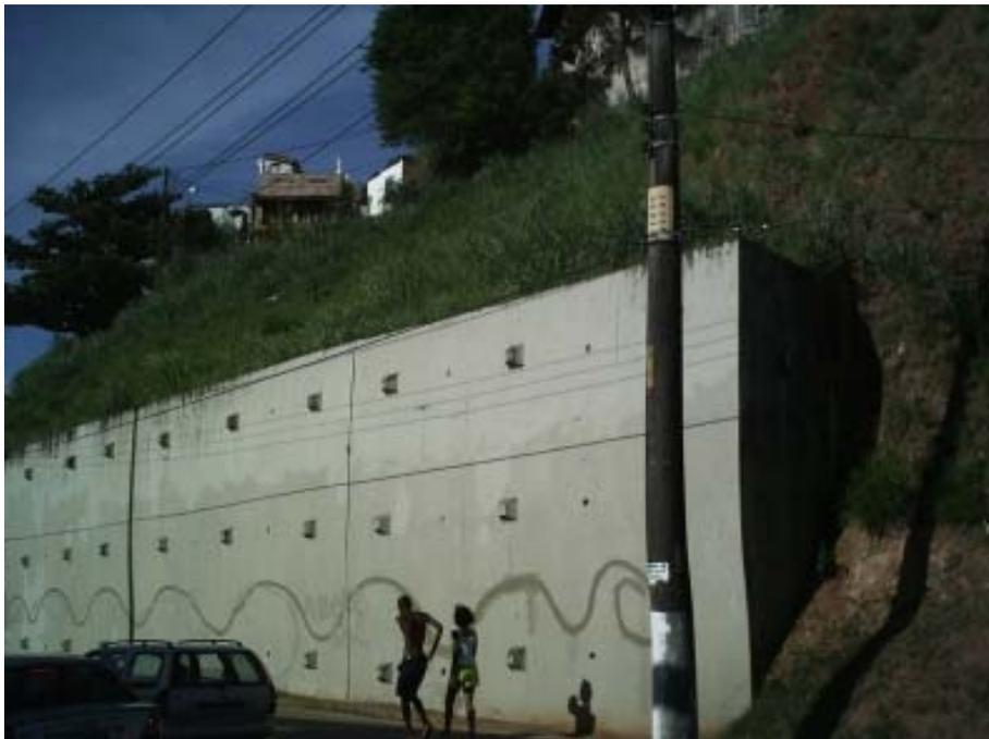
Figura 24 – Fotografia de uma contenção de cortina atirantada na ligação entre a Av. Vasco da Gama e o Dique do Tororó (P02).
