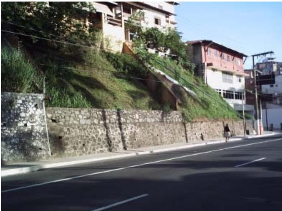
Figura 26 – Fotografia de uma alvenaria de pedra na base do talude localizado no Dique do Tororó (P07).
