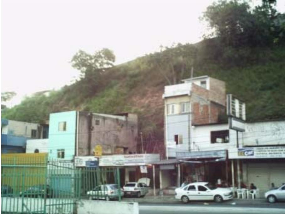
Figura 29 – Fotografia de um talude íngreme e pouco vegetado apresentando construções em sua base no Vale do Ongunjá (P13).
