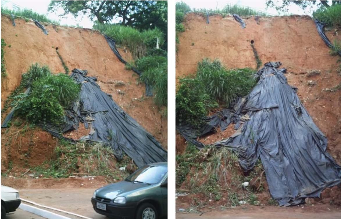
Figura 27 – Fotografia de uma (a) cicatriza de um escorregamento, onde ocorreu o soterramento de um carro, ocorrido em março de 2005 e (b) do rompimento da tubulação de esgoto, em condomínio residencial (P11).
