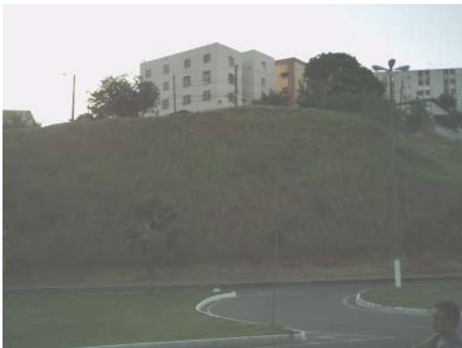
Figura 28 – Talude íngreme totalmente vegetado no Vale do Ogunjá (P12).
