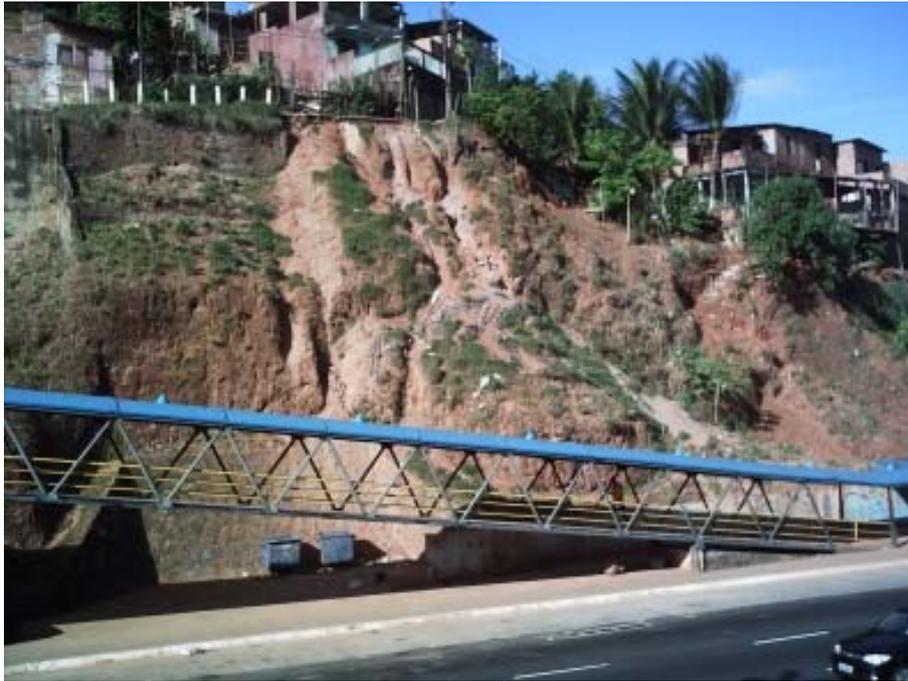
Figura 23 – Fotografia de um talude de 8 a 10 metros com pouca vegetação, apresentando sulcos de erosão (P01).
