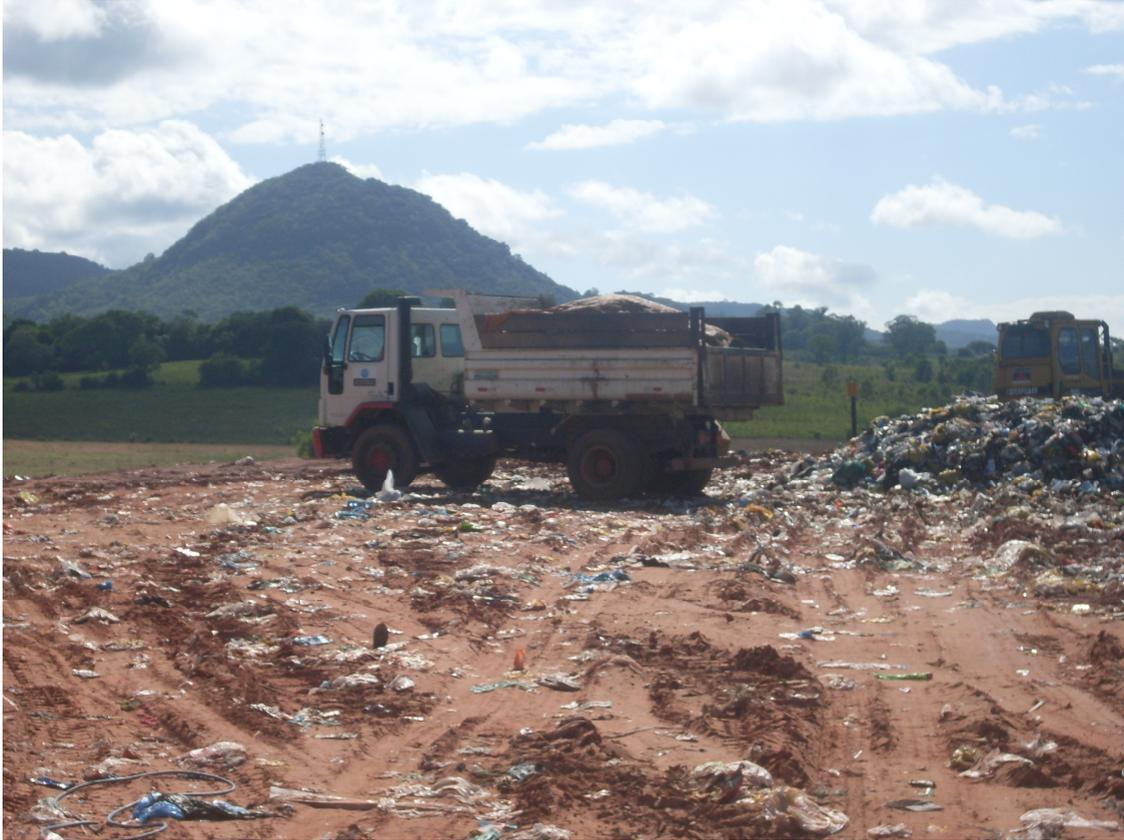
Figura 5.25 – Caçambas em serviço de recobrimento
