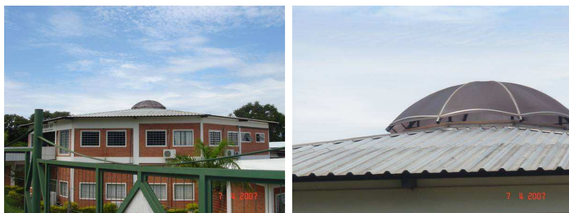
Fig. 129: SEMA - Secretaria do Meio Ambiente, cobertura metálica sextavada, com sistema de ventilação. (Foto: Büttner, S.)
