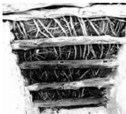
Fig. 14: Construção com cobertura abobadada, composta de terra vulcânica, algas, cana e estrutura de madeira. Fig. 15: Estrutura de madeira com recobrimento de folhas e galhos. (Fonte: YANNAS; ERELL; MOLINA, 2006)
