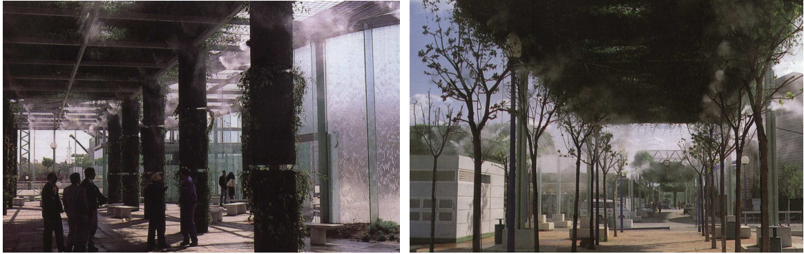
Fig. 45: Resfriamento direto na World Expo, Sevilha – Espanha (esq.) e Fig. 46: Aspersão d'água sob cobertura, em espaços abertos – 1992 World Expo, Sevilha – Espanha (dir.) (Fonte: GUERRA, 1994)
