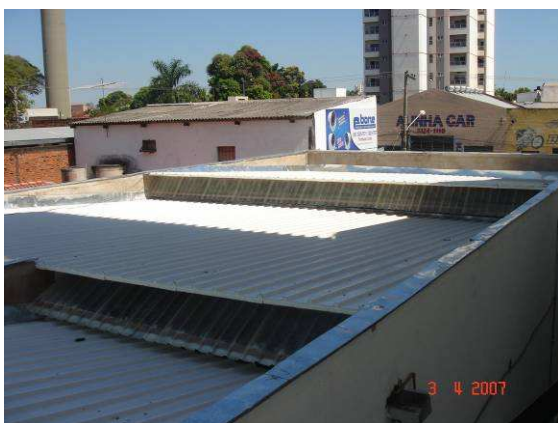
Fig. 122: Cobertura de telha metálica isolante com enchimento em poliestireno expandido, em galpão comercial na av. Barão de Melgaço. Fig. 123: Ginásio poliesportivo, no bairro Verdão, com cobertura curva de telha metálica tipo sanduíche e enchimento em poliuretano expandido. (Foto: Büttner, S.)
