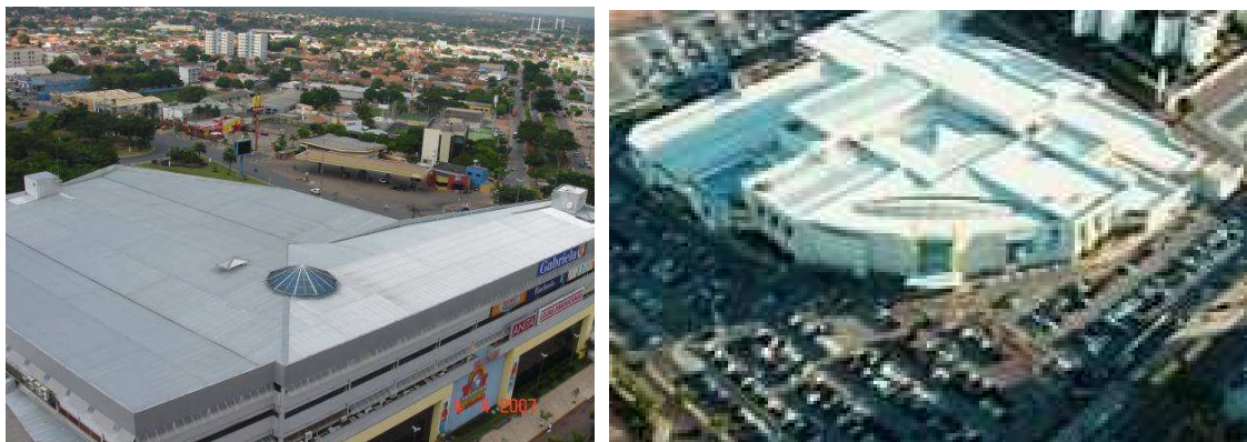
Fig. 138: Shopping Três Américas: telhas metálicas simples. (Foto: Büttner, S.)
