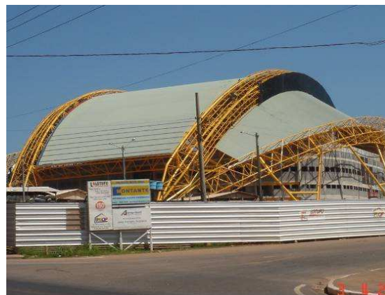
Fig. 122: Cobertura de telha metálica isolante com enchimento em poliestireno expandido, em galpão comercial na av. Barão de Melgaço. Fig. 123: Ginásio poliesportivo, no bairro Verdão, com cobertura curva de telha metálica tipo sanduíche e enchimento em poliuretano expandido. (Foto: Büttner, S.)
