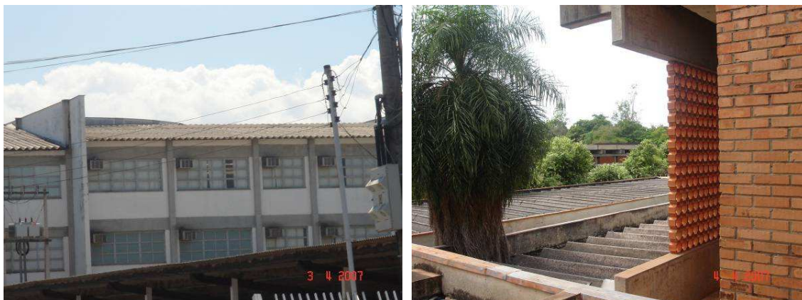
Fig. 126: Universidade de Cuiabá - UNIC e Fig. 127: Faculdade de Tecnologia e Engenharias da Universidade Federal de Mato Grosso – UFMT, respectivamente. Ambas cobertas por telhas de cimento amianto, forradas internamente.
