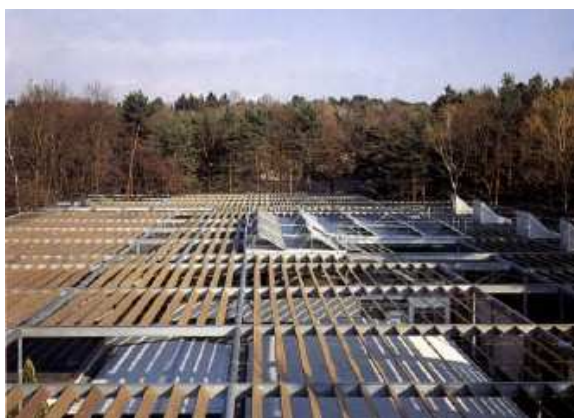
Fig. 2: Cobertura sombreada por lâminas de madeira, em edifício do Centro de Pesquisas da Comissão Européia, Em Ispra – Itália. (Fonte: YANNAS, ERELL e MOLINA, 2006)
