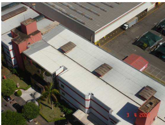
Fig. 120: Cobertura metálica (com forro) do hospital Santa Rosa (dir.) e Fig. 121: Telhas metálicas com forro isolante, intercaladas com telhas translúcidas, no supermercado MAKRO (esq.). (Foto: Büttner, S.)
