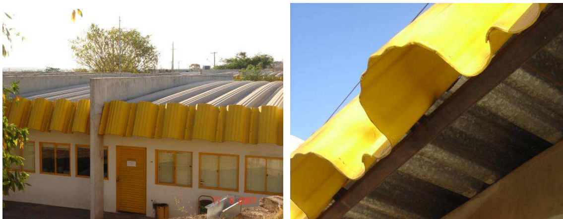
Fig. 132: Parte das instalações do Detran – cobertura com telha metálica simples . (Foto: Büttner, S.)
