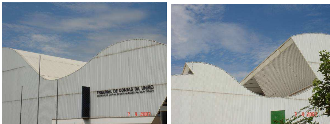
Fig. 128: Tribunal de Contas da União: Cobertura metálica ondulada, com sistemas de aberturas, projeto do arq. Lelé.
