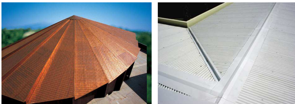
Fig. 86 e Fig. 87: Cobertura de cobre (esq.) e aço galvanizado (dir). (Fonte: DÂNICA. Disponível em: http://www.danicacorporation.com e TCSHINGLE. Disponível em: < www.tcshingle.com.br >)
