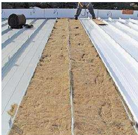
Fig. 102: As telhas sanduíches recebem lã de rocha, de vidro ou ainda espumas plásticas no miolo entre duas lâminas.
