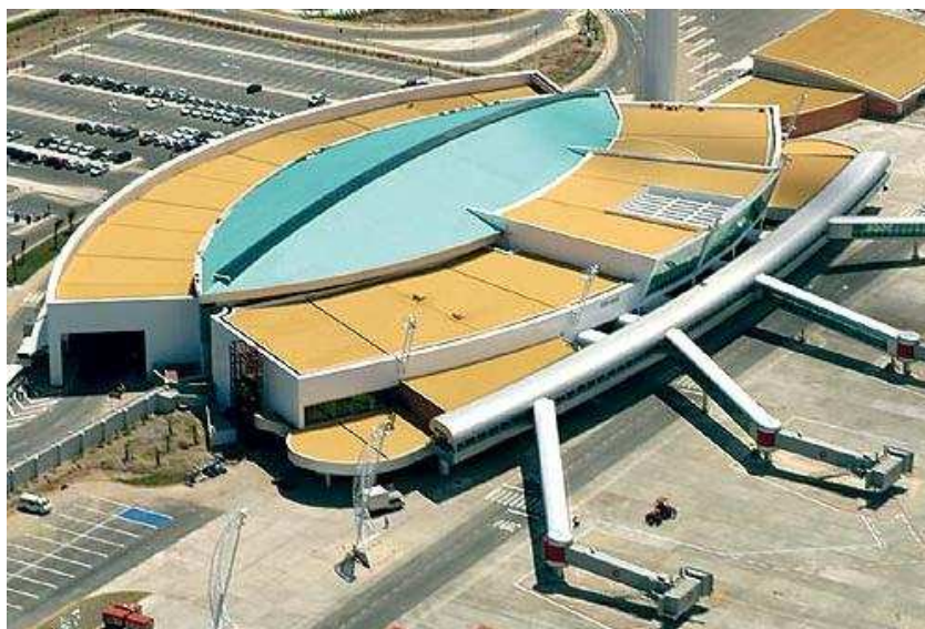
Fig. 94: Aeroporto de Maceió – AL. (Fonte: ARQUITETURA..., 2001)
