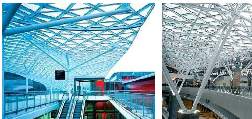
Fig. 93: Cobertura de vidro do Aeroporto de Recife – PE. (Fonte: MORETI... 2005)
