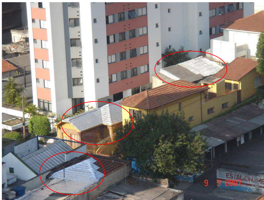
Fig. 104: Demonstração de como as barreiras radiantes são aplicadas equivocadamente do lado externo da cobertura, em São Paulo. (Foto: Büttner, S.)
