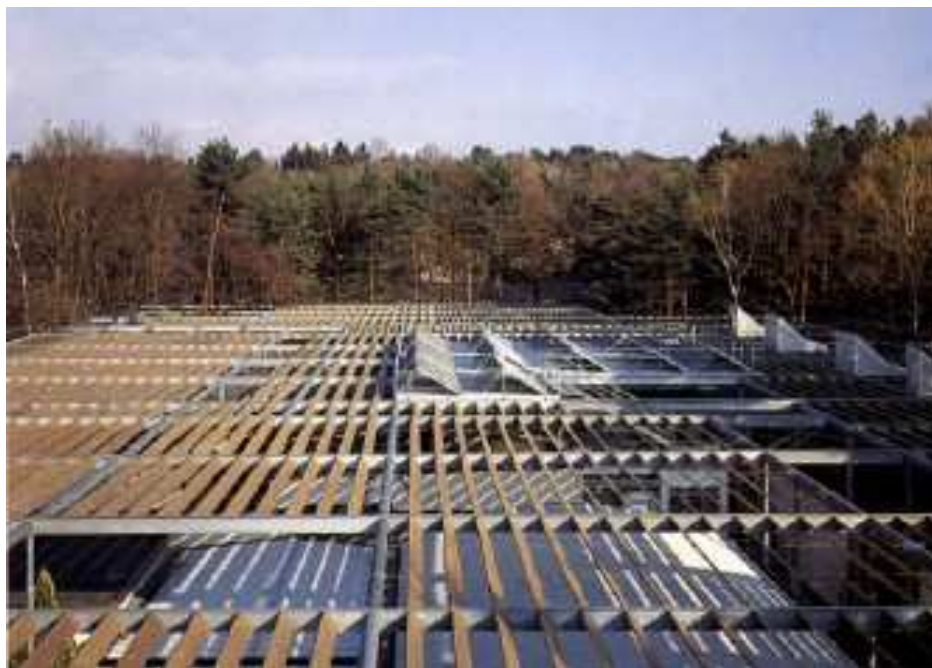
Fig. 33: Cobertura sombreada parcialmente por lâminas de madeira, na Itália. (Fonte: YANNAS;ERELL; MOLINA, 2006)
