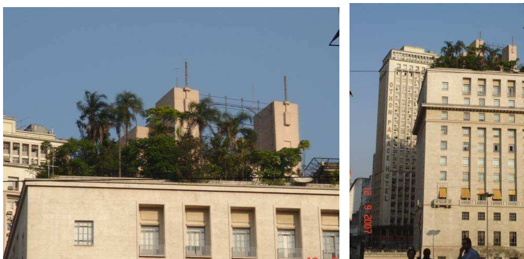
Fig. 58 e Fig. 59: Cobertura “verde” do Edifício Sede da Prefeitura do Município de São Paulo, no centro da cidade.
