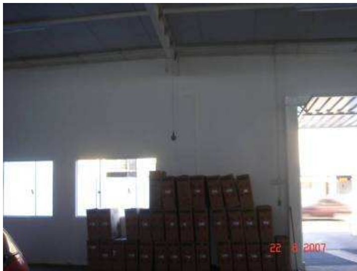
Fig. 164: Ponto interno de medição no galpão 02: próximo à fachada NW. (Foto: BUTTNER, S.)
