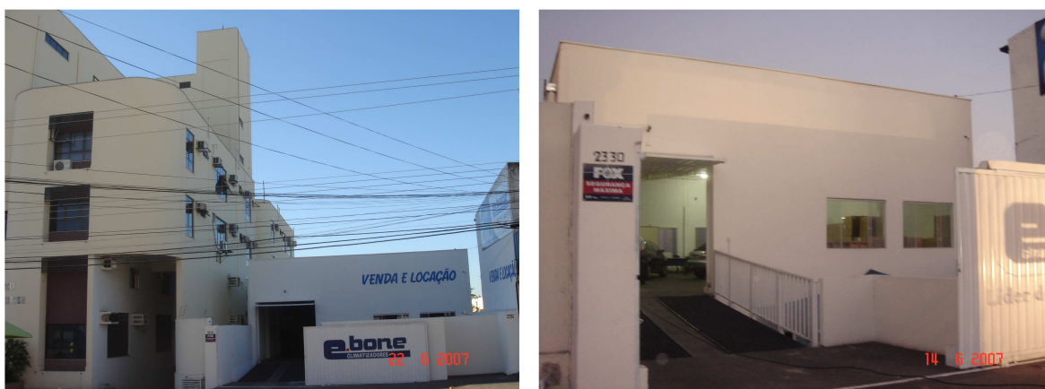
Fig. 152: Vistas da fachada frontal do galpão 02 com entorno. (Foto: BUTTNER, S.)
