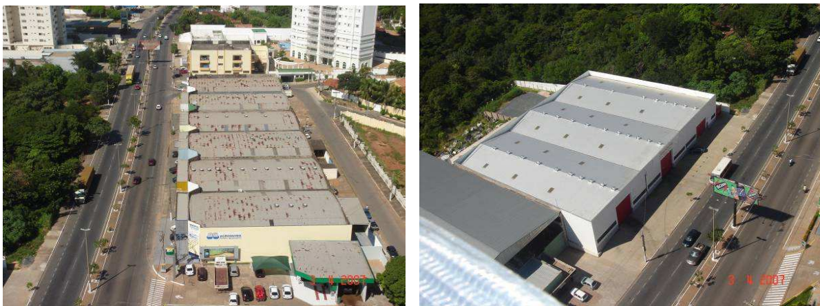
Fig. 118: Galpões na Av. Miguel Sutil - Coberturas metálicas com exaustores.(Foto: Büttner, S.)
