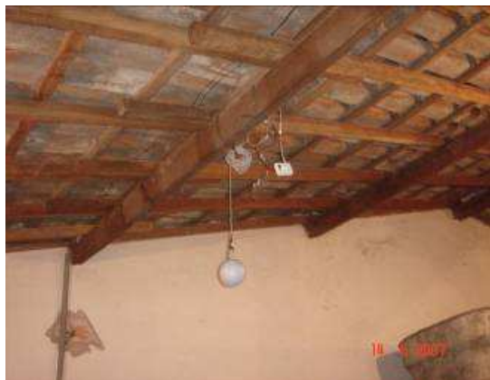
Fig. 151: Ponto 02 de medição (mezanino) do galpão 01. (Foto: BUTTNER, S.)
