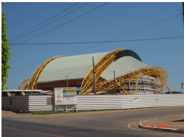
Fig. 1: Cobertura metálica de Ginásio poliesportivo, em Cuiabá / MT. (Foto: S. Büttner)
