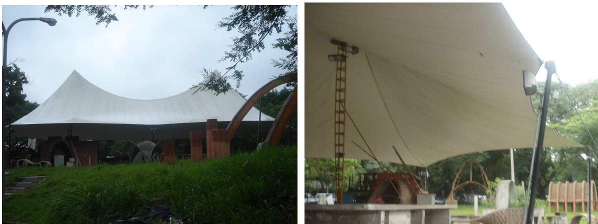
Fig. 92: Canteiro experimental Domingos Bataglia da Faculdade de Arquitetura e Urbanismo da Universidade de São Paulo (FAU USP). (Fonte: BÜTTNER, S.)
