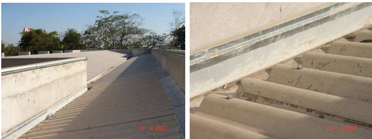
Fig. 125: Edifício novo do Instituto de Educação da UFMT – Cobertura com telha metálica simples e forro. (Foto: Büttner, S.)
