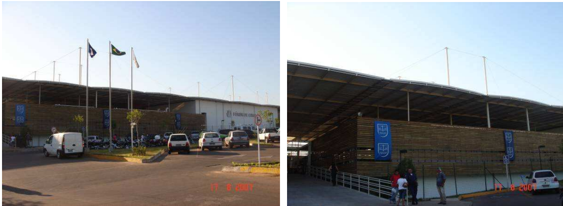
Fig. 134: Fórum de Cuiabá: Cobertura atirantada, ora metálica ora translúcida, com largo espaço entre esta e a laje, permitindo a ventilação e a manutenção técnica. (Foto: Büttner, S.)
