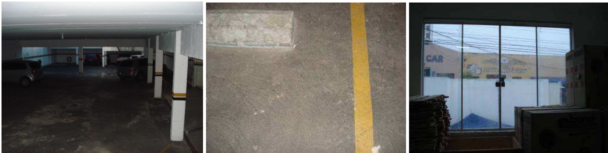
Fig. 155: Subsolo/garagem. Fig. 156: Piso cimentado. Fig. 157: Janela no térreo com folhas de correr de vidro comum transparente. (Foto: BÜTTNER, S.)
